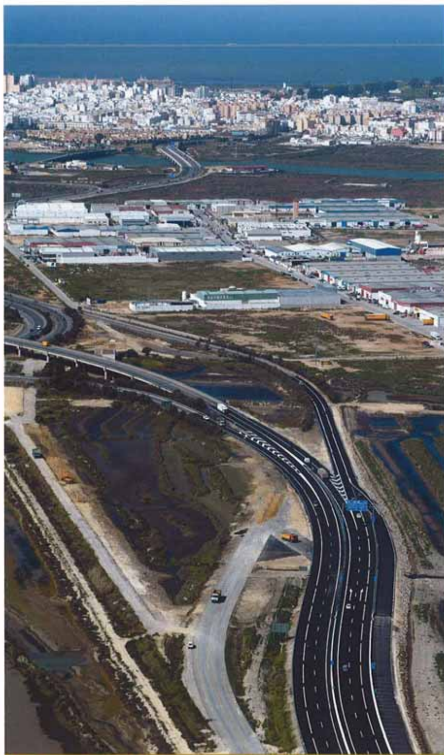
En los últimos 22 meses se ha ejecutado el 90% de la obra.
