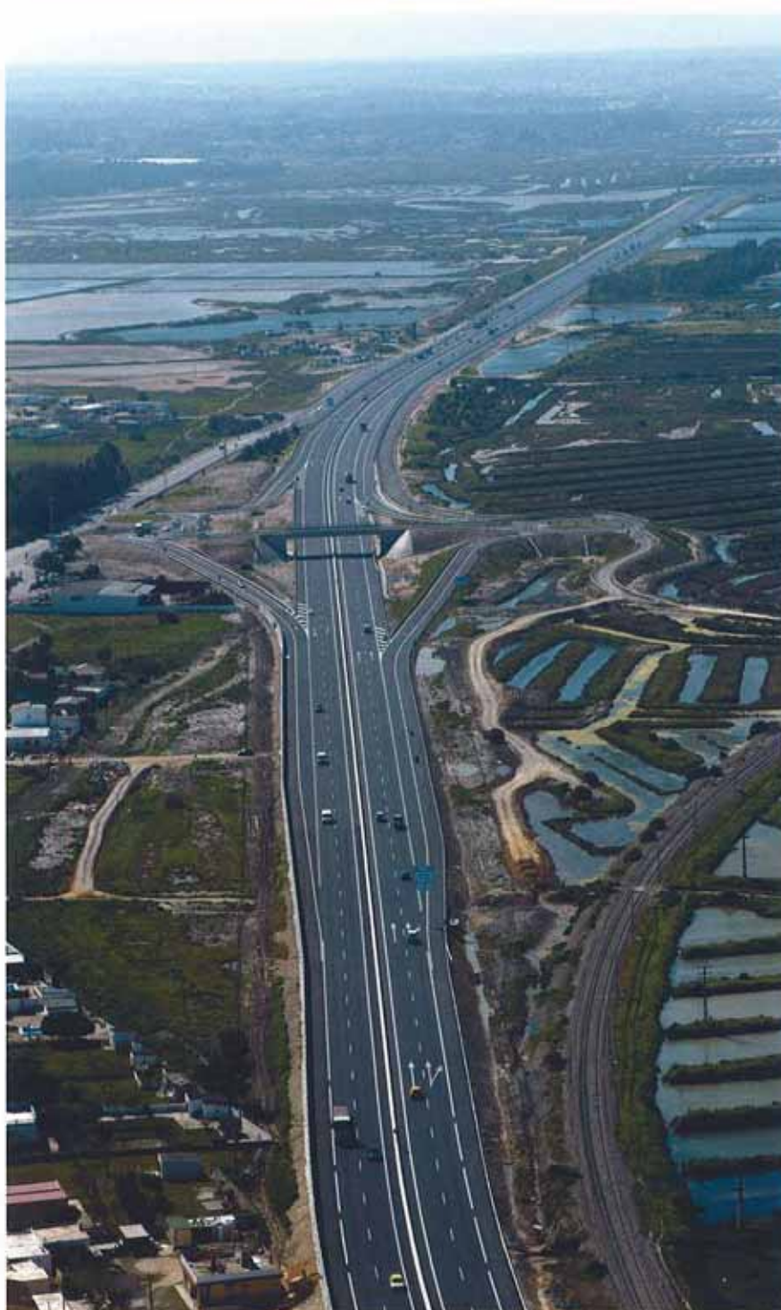
El tramo tiene una longitud de 7 km, y su construcción ha supuesto una inversión de 22,05 millones de euros.
