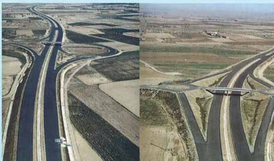
Tramo Teruel (Norte)-Santa Eulalia del Campo. Enlaces de Caudé (izquierda) y Villarquemado (derecha).
