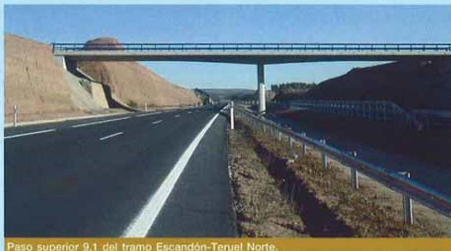
Paso superior 9.1 del tramo Escandón-Teruel Norte.
