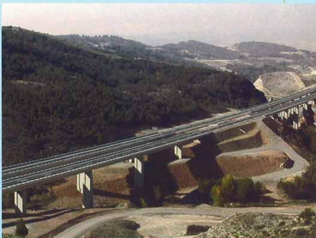
Viaductos E-4 y E-5 del tramo Escandón-Teruel Norte.
