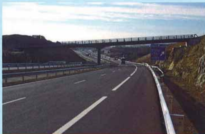
Paso superior en el p.k. 13+050 del tramo Enlace de Sarrión-Variante de Teruel.
