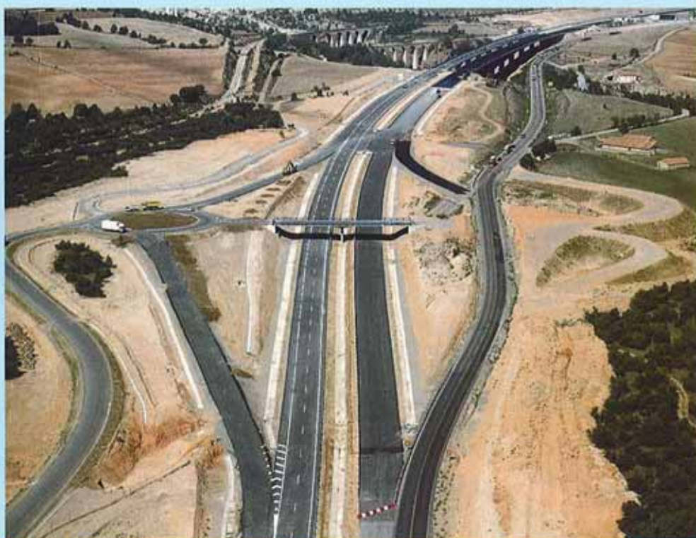
El tramo Enlace de Sarrión-Variante de Teruel tiene una longitud de 20,6 km.
