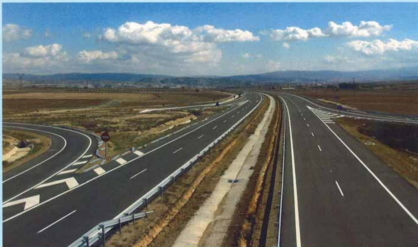
Vista panorámica del tramo Teruel (Norte)-Santa Eulalia del Campo, de casi 27 km de longitud.
