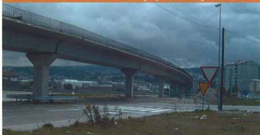
A lo largo del trazado se han construido 7 viaductos.
