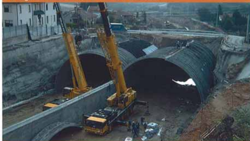
Vista de la fase de construcción de los dos túneles artificiales en la parroquia de Valladares.
