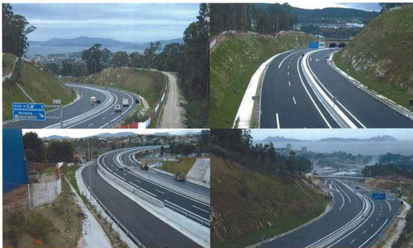
Diversas panorámicas del tramo inaugurado.
