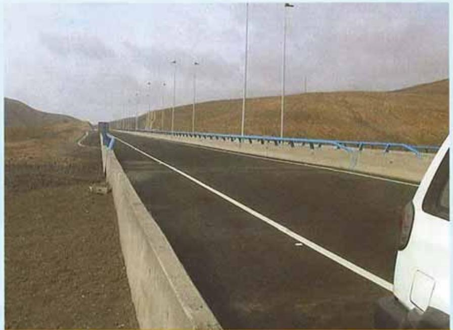
Las calzadas está separadas por dos barreras, tipo New Jersey, distanciadas por los 2 m de mediana, en la que han sido instalados postes de iluminación.
