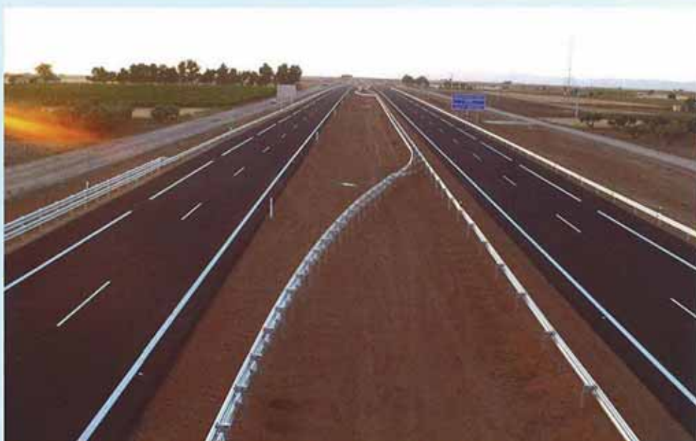
Las calzadas son las típicas de autovía con una mediana de 14 m.
