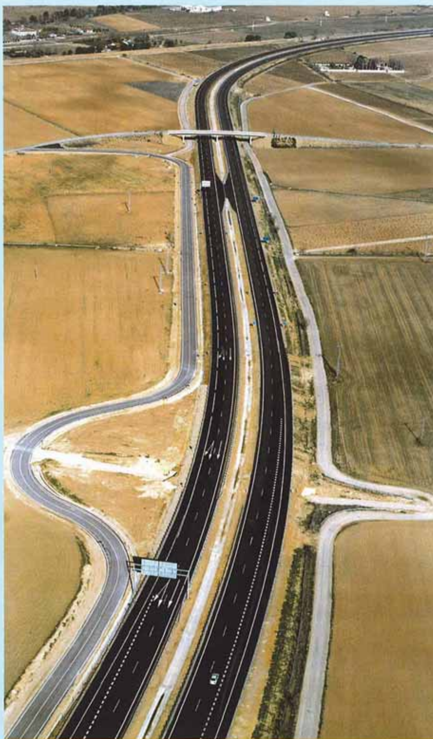
La calzada es la característica de autovía, con mediana de 10 m de anchura y bermas de 1 m.
