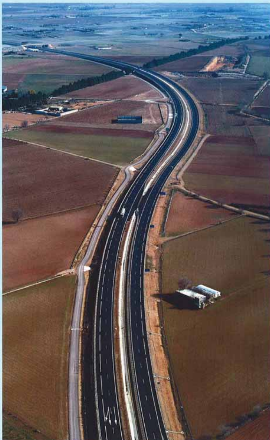
El tramo puesto en servicio discurre desde el oeste de Argamasilla de Alba y el este de Tomelloso (Ciudad Real).
