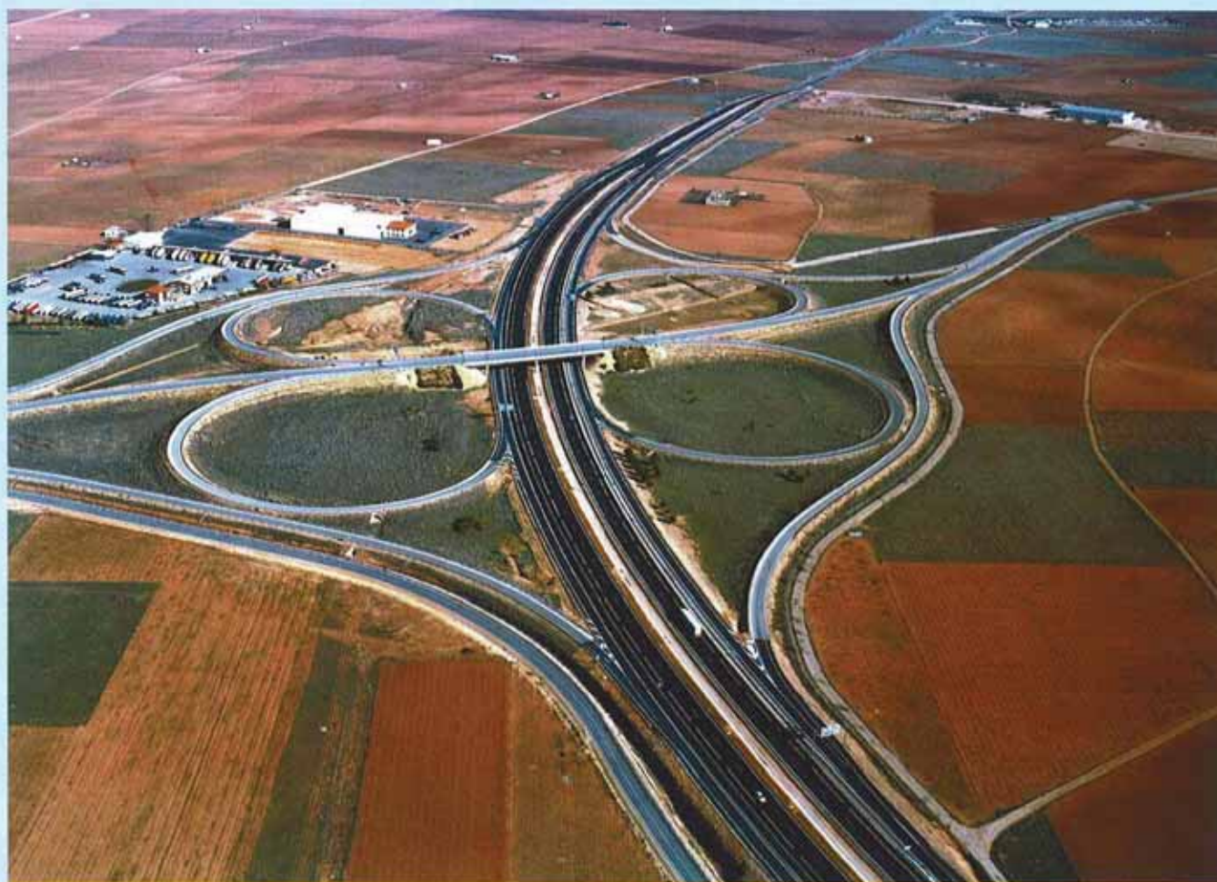
La adecuada permeabilidad transversal de la autovía evita el efecto barrera que una obra de este tipo pudiera llegar a crear.
