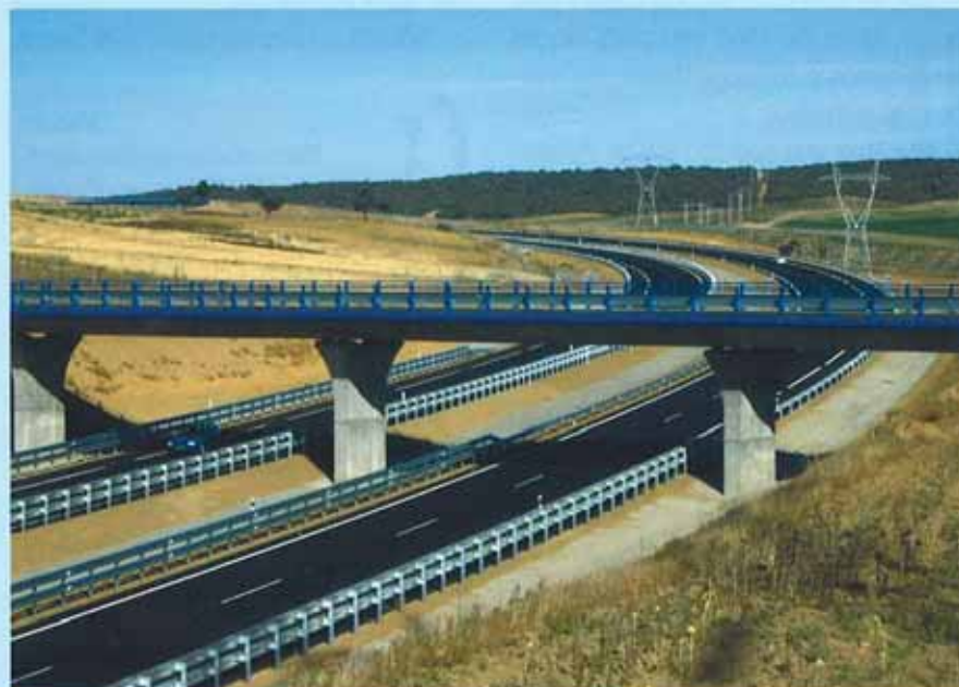
A lo largo del tramo, se han dispuesto un total de 24 pasos superiores para cruces de carreteras y caminos.
