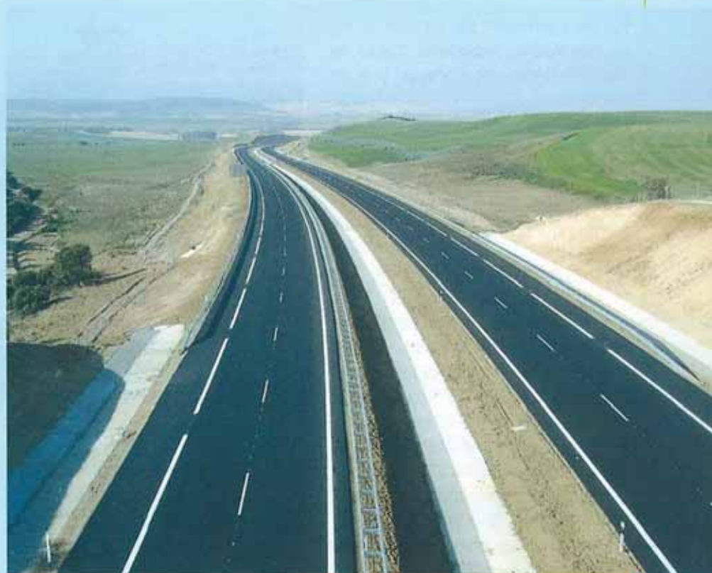
La sección transversal es la característica de una autovía con una mediana de 10 m de anchura.
