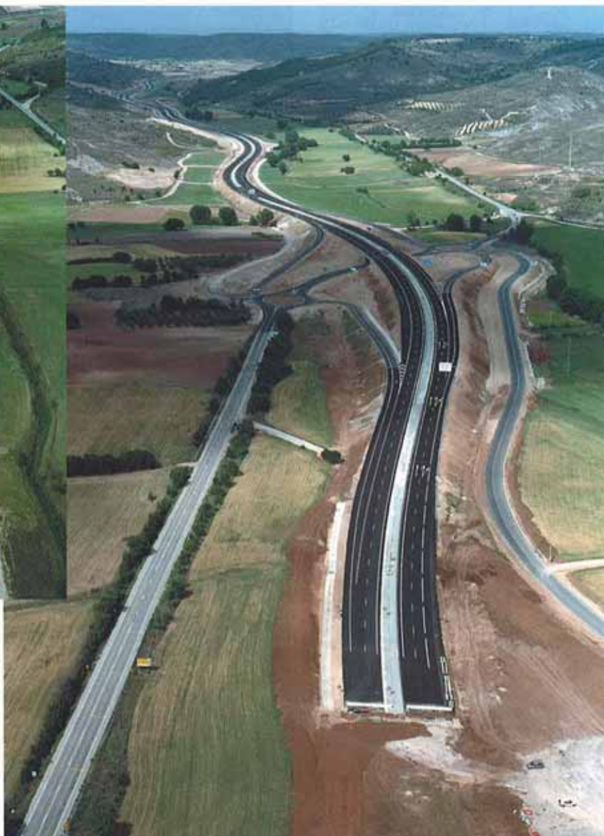
A lo largo del itinerario se han construido 3 enlaces, 11 pasos inferiores, 3 pasos superiores y 1 puente sobre el río Cigüela.
