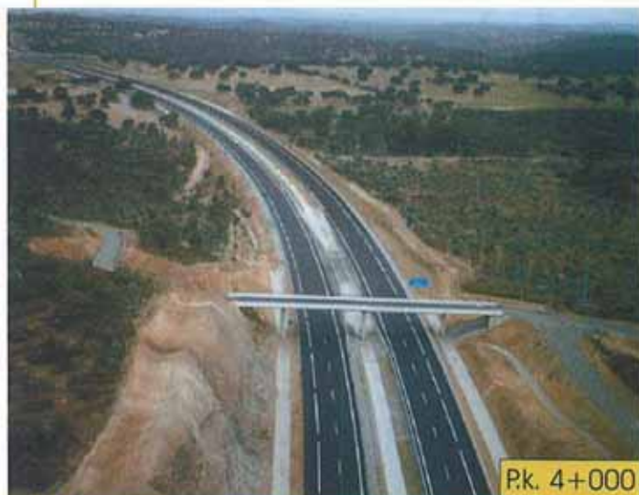
En la foto, uno de los tres pasos superiores dispuestos en el tramo
