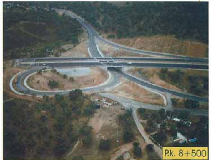
Estructuras al final del tramo.
