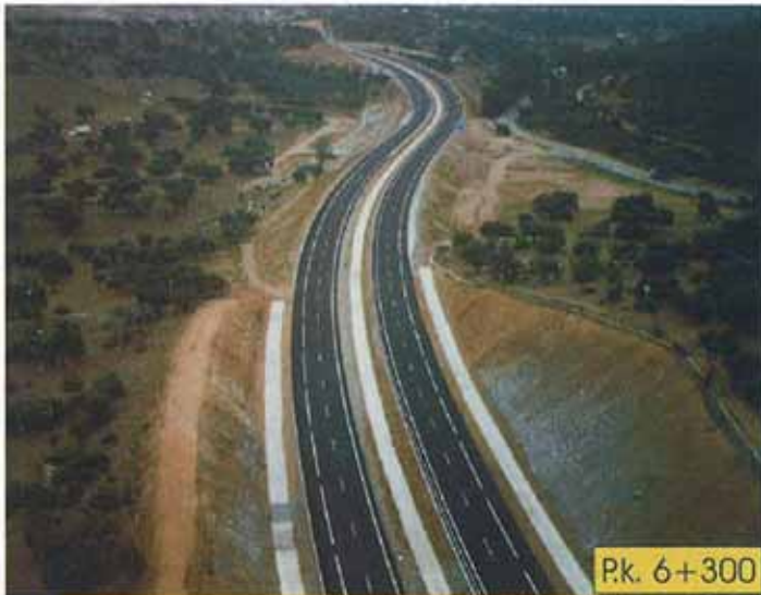
El tramo dispone de una sección transversal con características de autovía.
