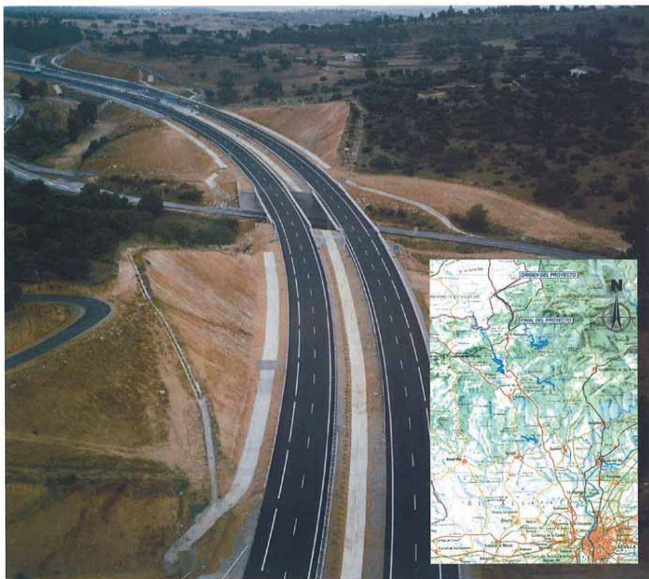
El tramo puesto en servicio tiene una longitud troncal de 8,6 km y ha sido diseñado para una velocidad de 120 km/h.
