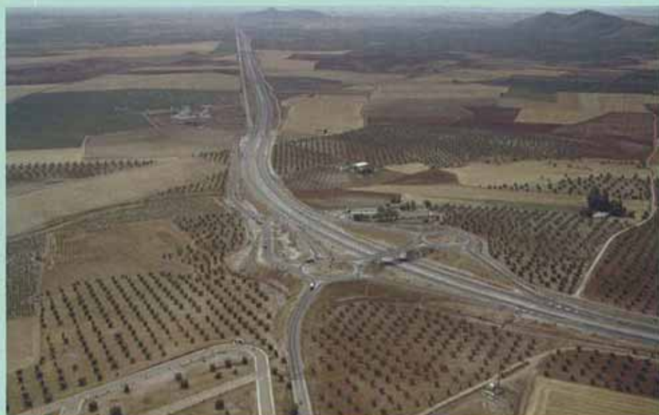
Con esta inauguración se completa el primer gran tramo Toledo-Consuegra de la autovía de los Viñedos.
