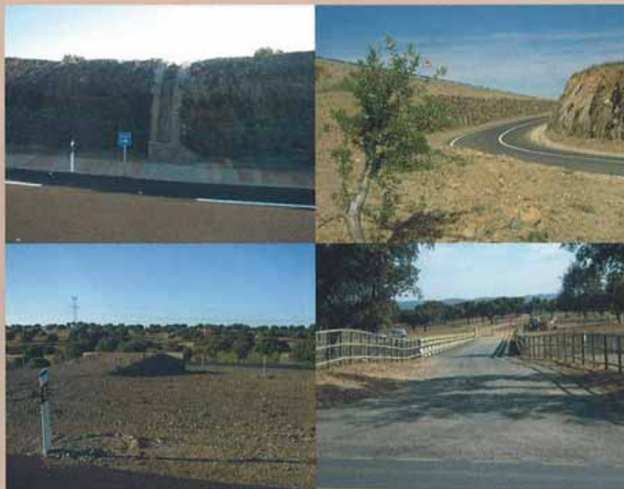
Dentro de las actuaciones ambientales, se han realizado bajantes encachados, rampas de escape para animales, escolleras y se han repuesto vías pecuarias.
