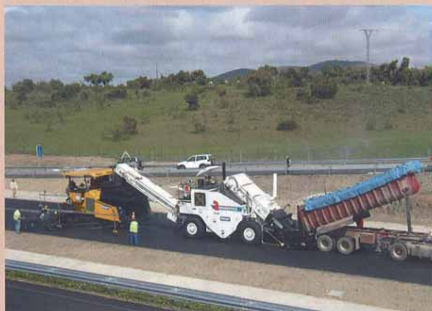
En el extendido de las mezclas bituminosas, se ha utilizado por primera vez en nuestro país, un silo móvil de transferencia de material o transfer , con capacidad para la homogeneización térmica y granulométrica de las mezclas tras la descarga desde el camión.
