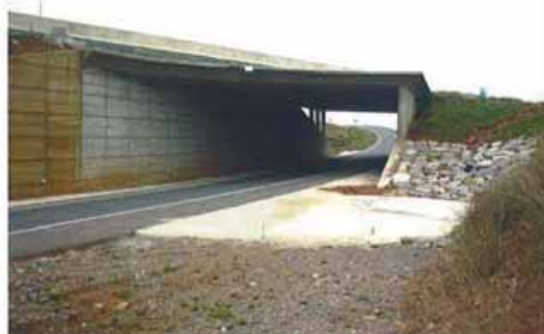
Estructura E-4+800. Pérgola (hormigón armado).
