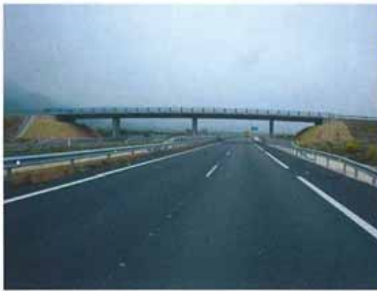
Estructura E-6+020 (Tablero losa postesada).
