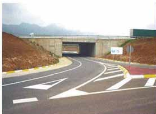
Estructura E-7+450 Paso inferior (marco de hormigón armado). Enlace Vilavella Norte.
