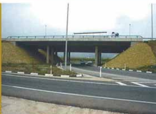
Estructura E -2+900 (Tableros de losas postesadas).
