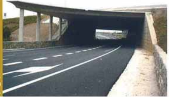
Estructura E-5+100. Pérgola (hormigón armado).
