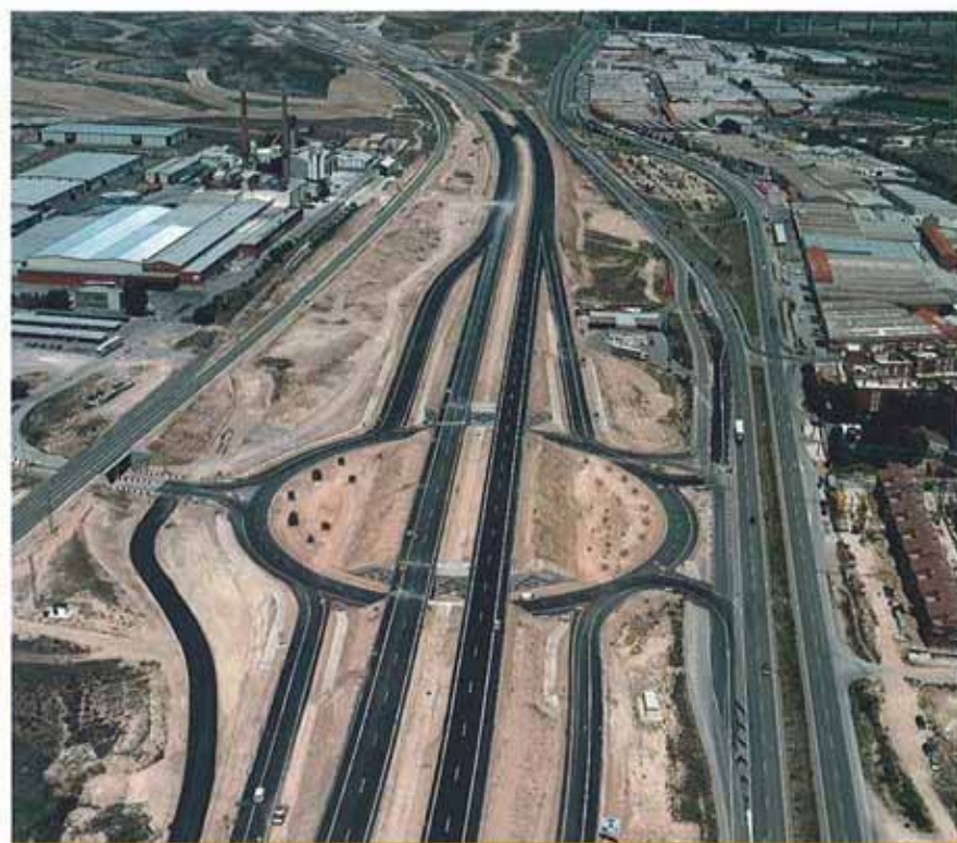
Enlace de Cuarte de Huerva, de tipo rotonda a desnivel.
