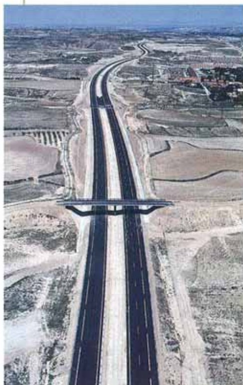
El tramo inaugurado tiene las características de una autovía diseñada para una velocidad de 120 km/h.
