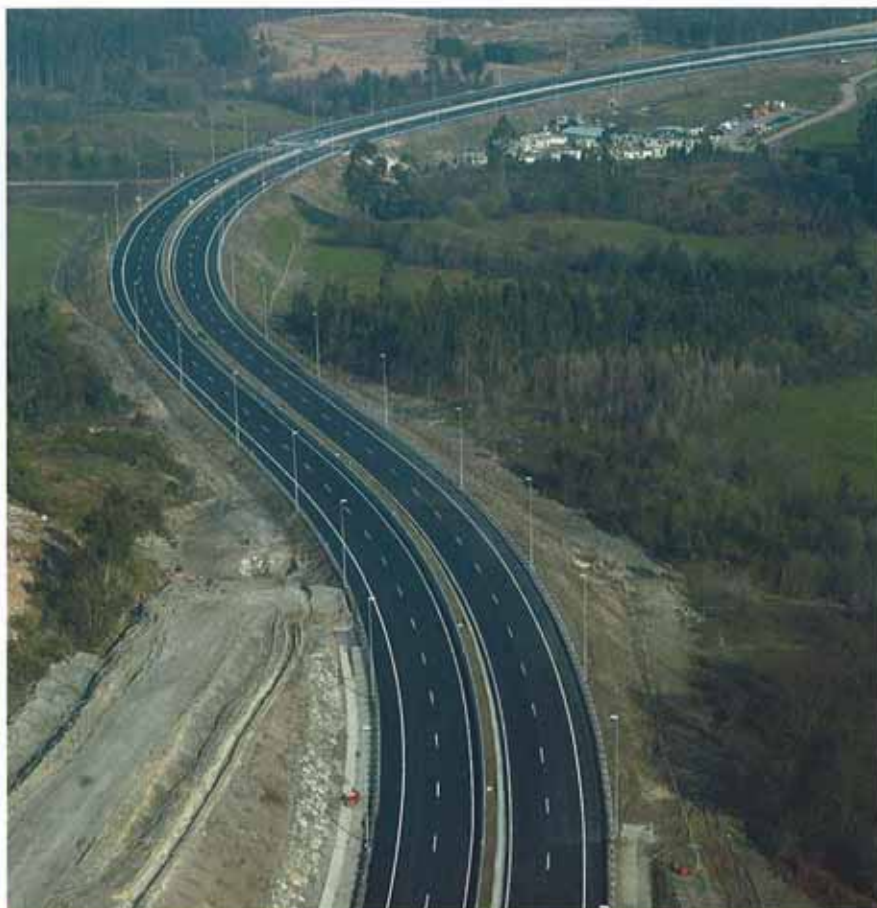
El tramo tiene una longitud troncal de algo más de 5 km. En la foto se aprecian las instalaciones de alumbrado que se han proyectado en el enlace, incluso de la variante comprendida entre el enlace del Aeropuerto y las instalaciones aeroportuarias.
