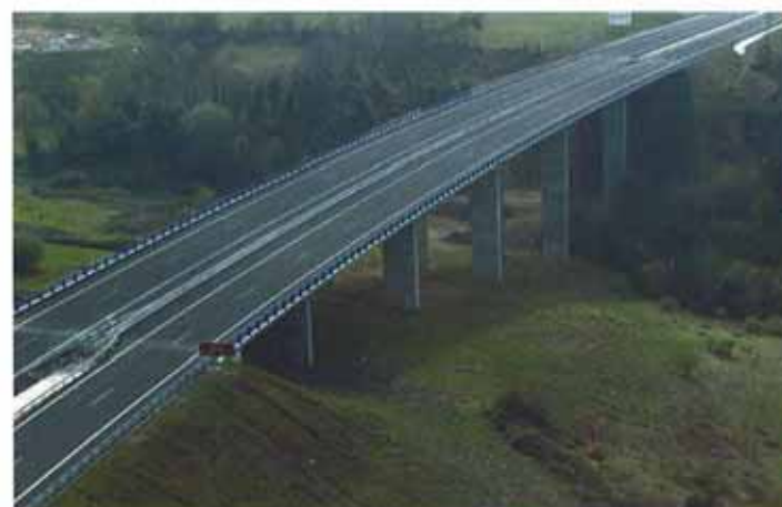
Viaducto del Alto de Praviano 2 (p.k. 2+782).
