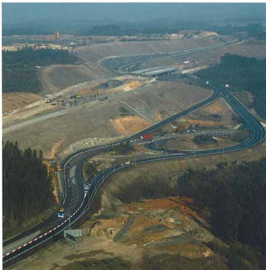
A lo largo del tramo se han dispuesto 1 enlace, 4 viaductos, 1 estructura sobre el enlace del Aeropuerto, 3 pasos superiores y otros 3 inferiores.
