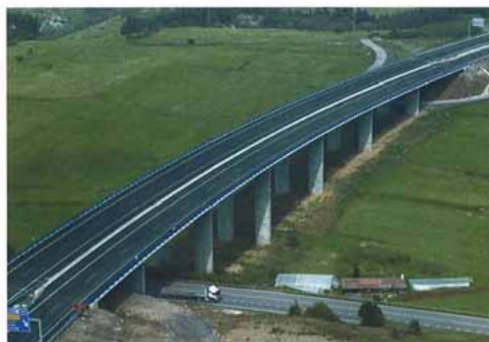
Viaducto del Alto de Praviano 1 (p.k. 2+346).
