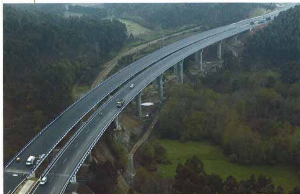
Viaducto de Vegarrozadas.
