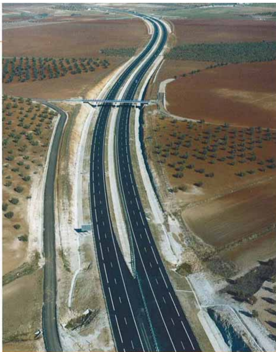
El tramo se inicia a unos 8 km al norte de Calzadilla de los Barros y finaliza unos 600 m al norte de Fuente de Cantos.
