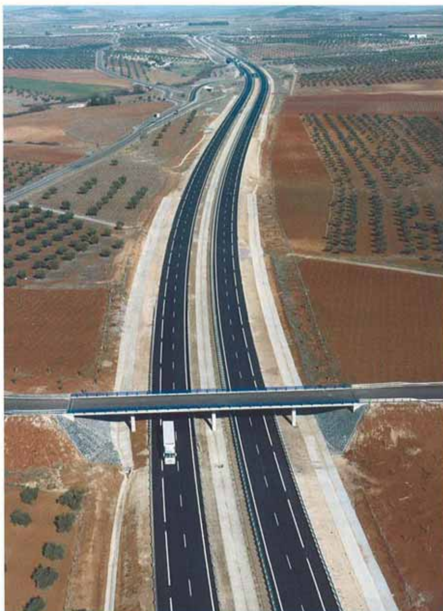
Con esta apertura al tráfico, la autovía A-66 tiene un total de 97,60 km en servicio en la comunidad extremeña.
