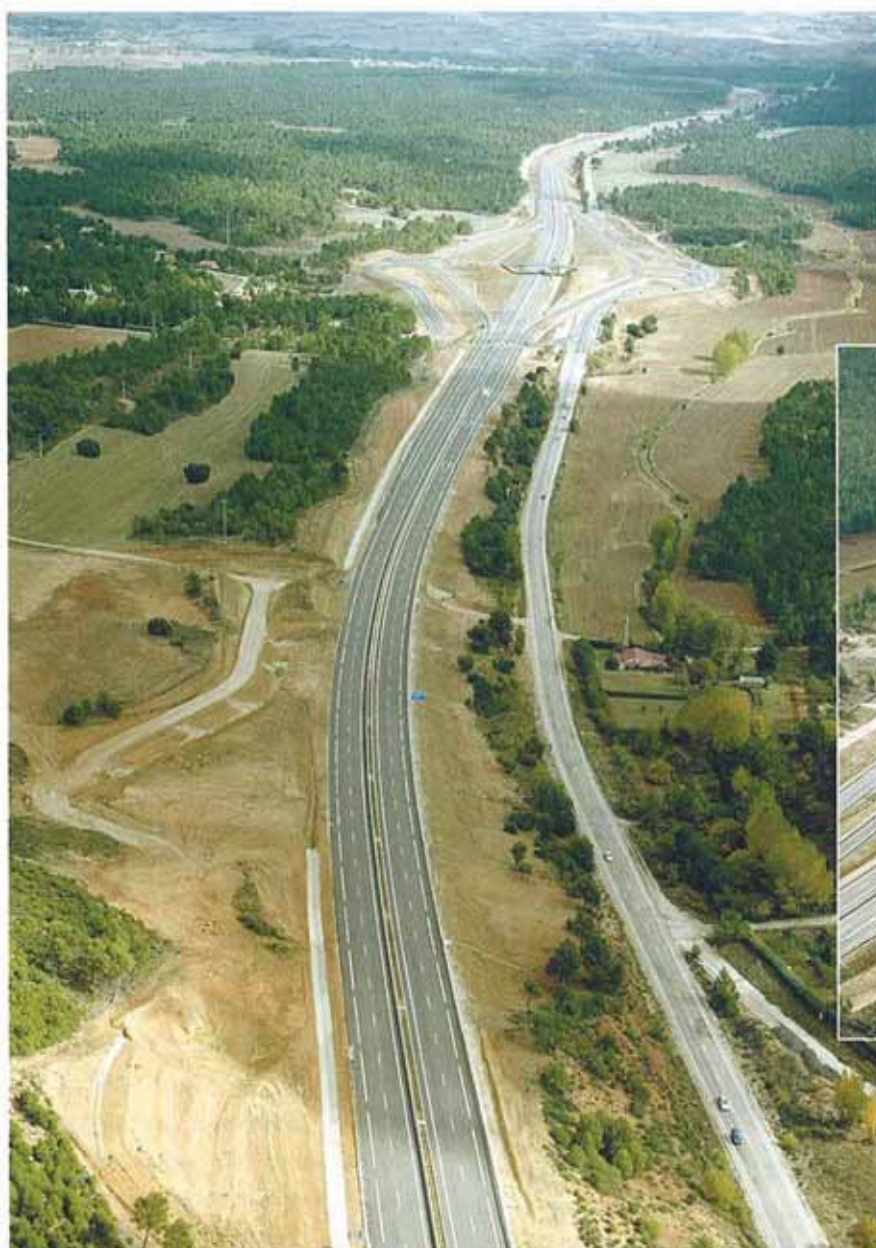
El nuevo tramo de la autovía de Castilla-La Mancha tiene una longitud total de 22,163 km.
