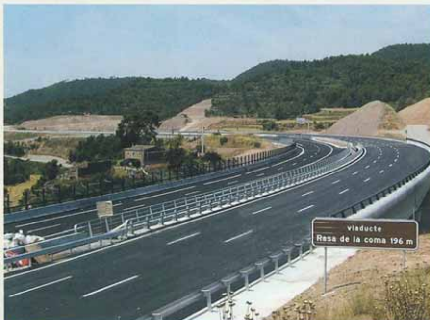
A lo largo del tramo se han construido 3 nuevos enlaces y 3 viaductos.
