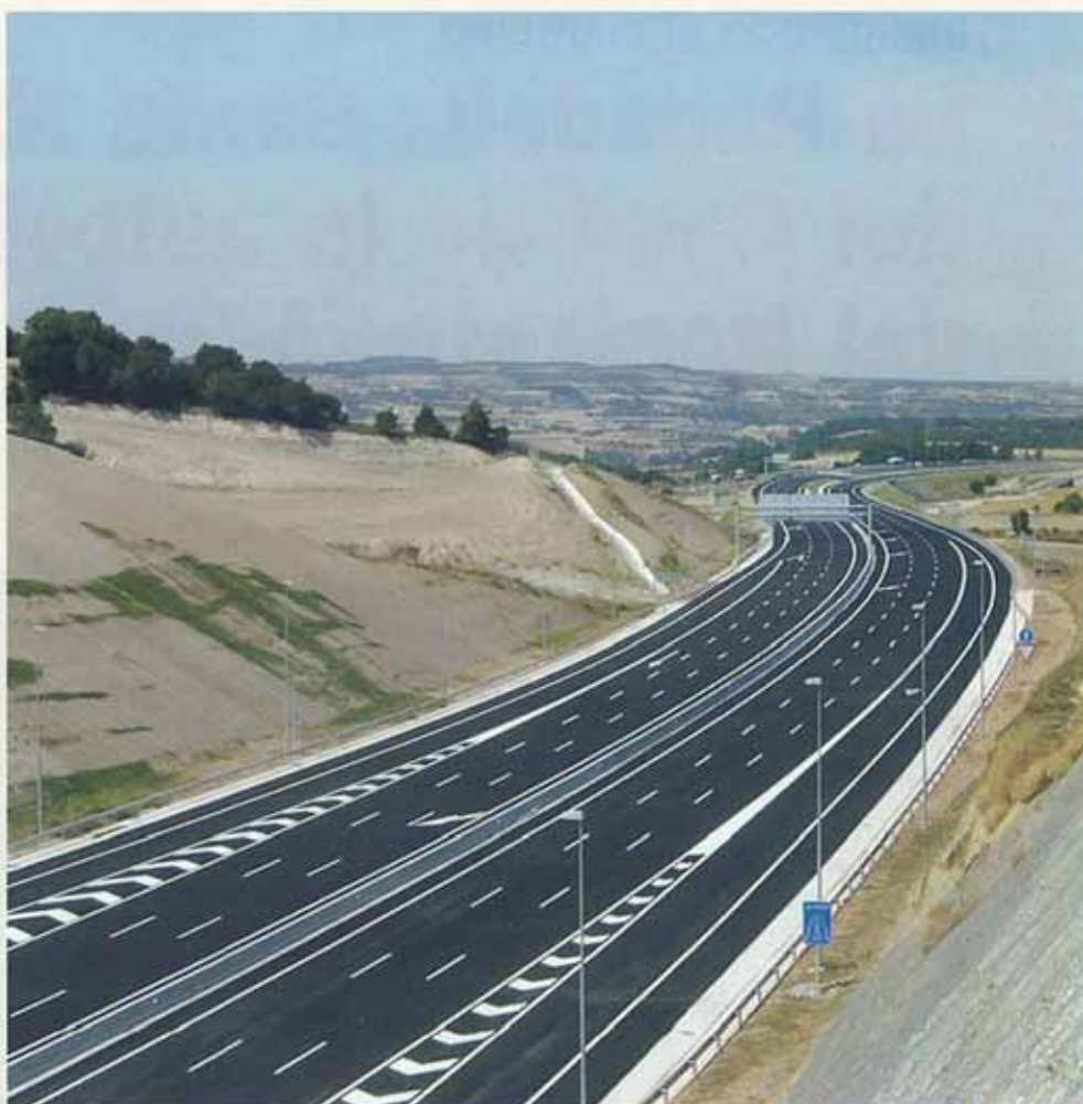
La longitud total del tramo es de 9,7 km, y ha supuesto una inversión de 87,5 millones de euros.
