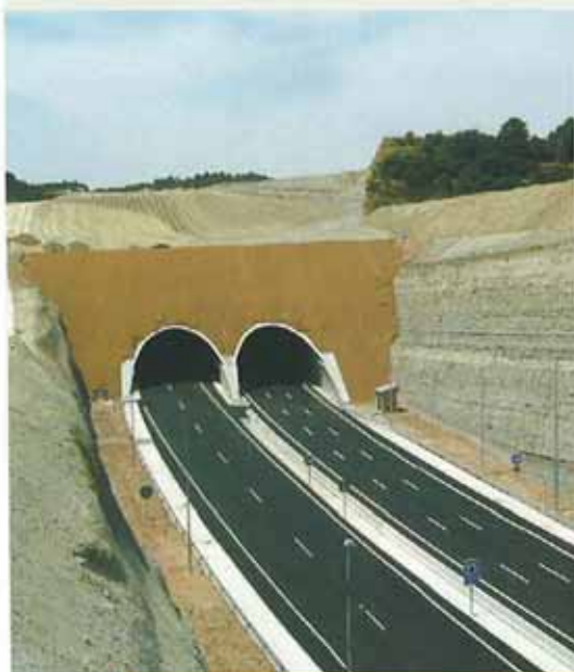
Vista del Túnel del Violl de 330 m de longitud.
