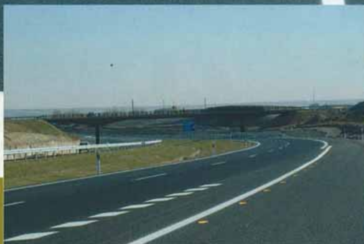
Vistas parciales de la autopista Radial R-4.
