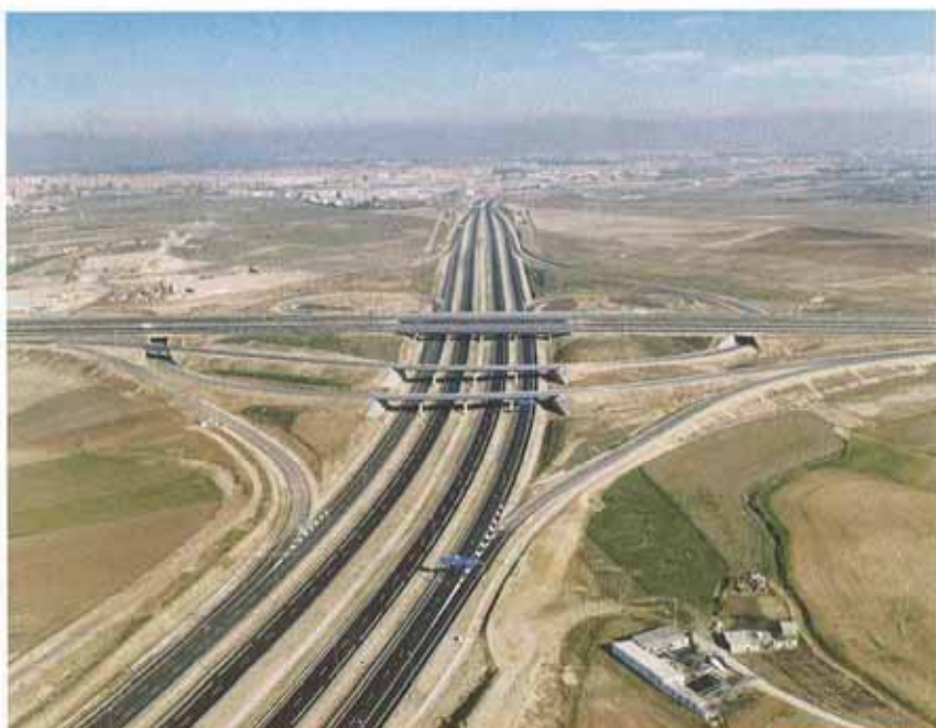
Vista parcial de la R-5, de 28,3 km de longitud troncal, y 77,4 km de longitud total, si se incluyen las vías colectoras y de servicio.
