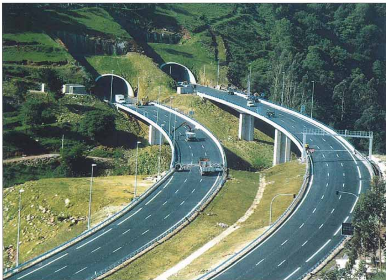
Túnel de Riocorvo (boca Norte) y viaducto de Arroyo Chico.
