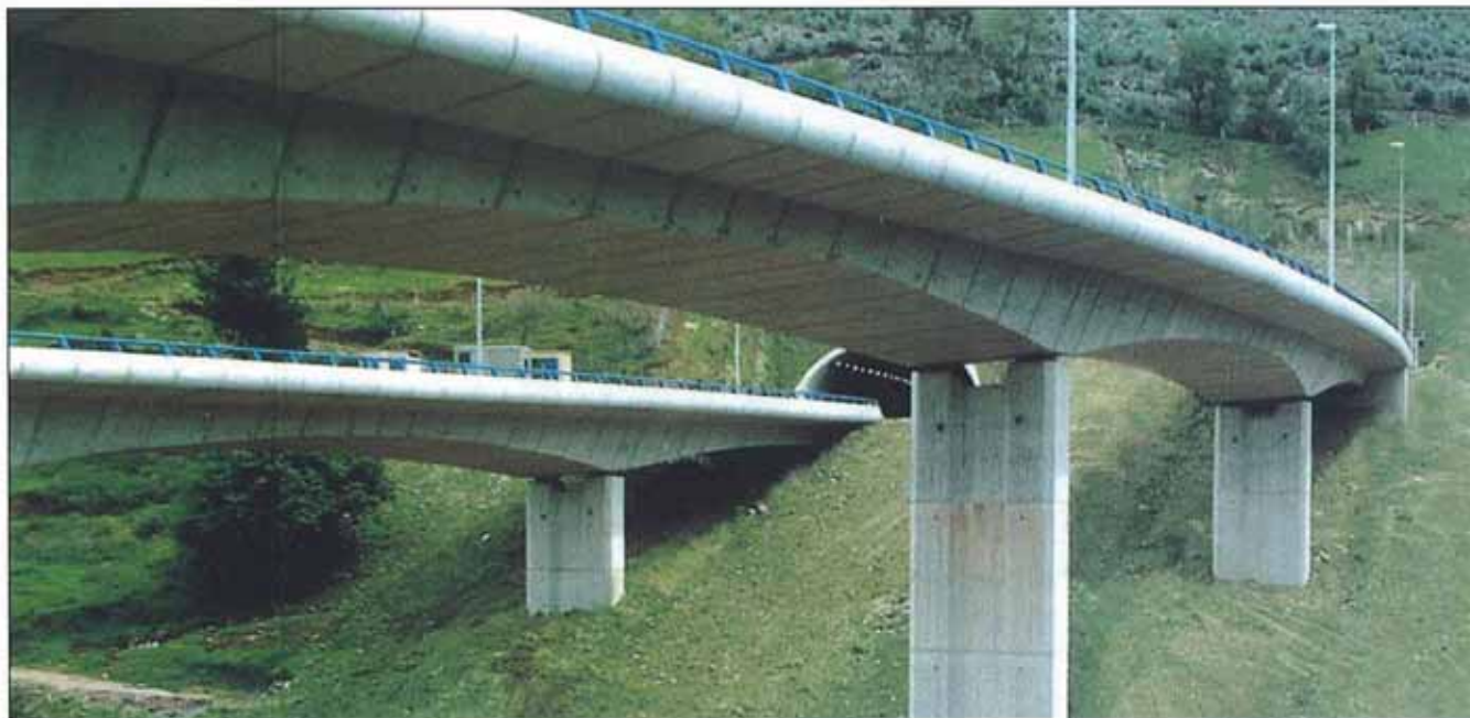
Viaducto de Arroyo Chico.
