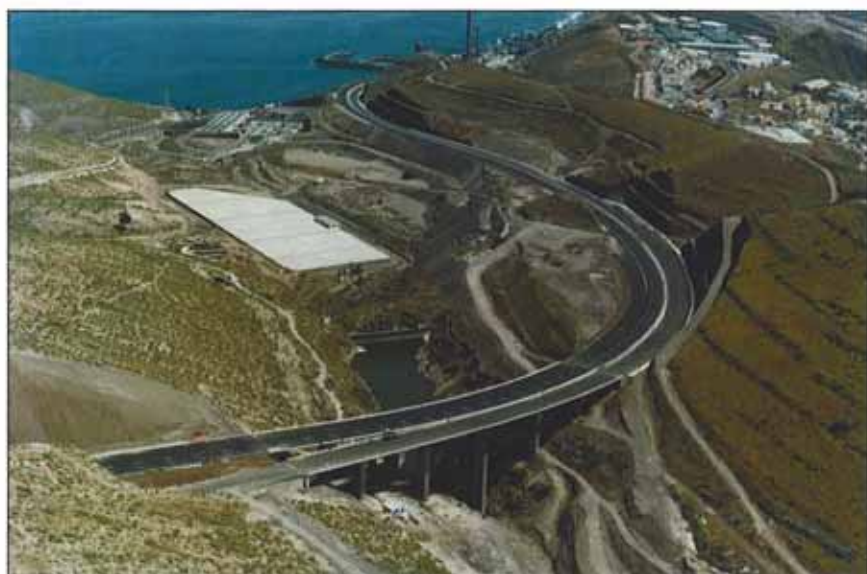
Viaducto de "El Sabinal".
