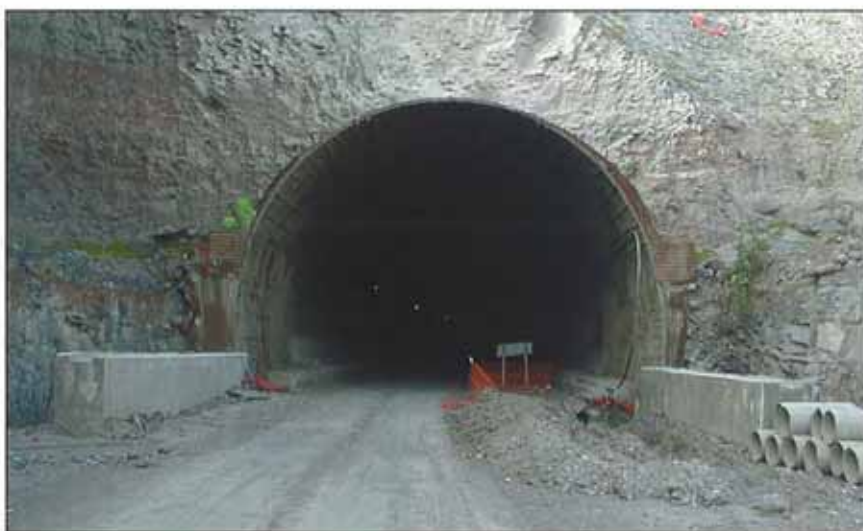
A lo largo de la Fase III se han construido un total de 9 túneles.
