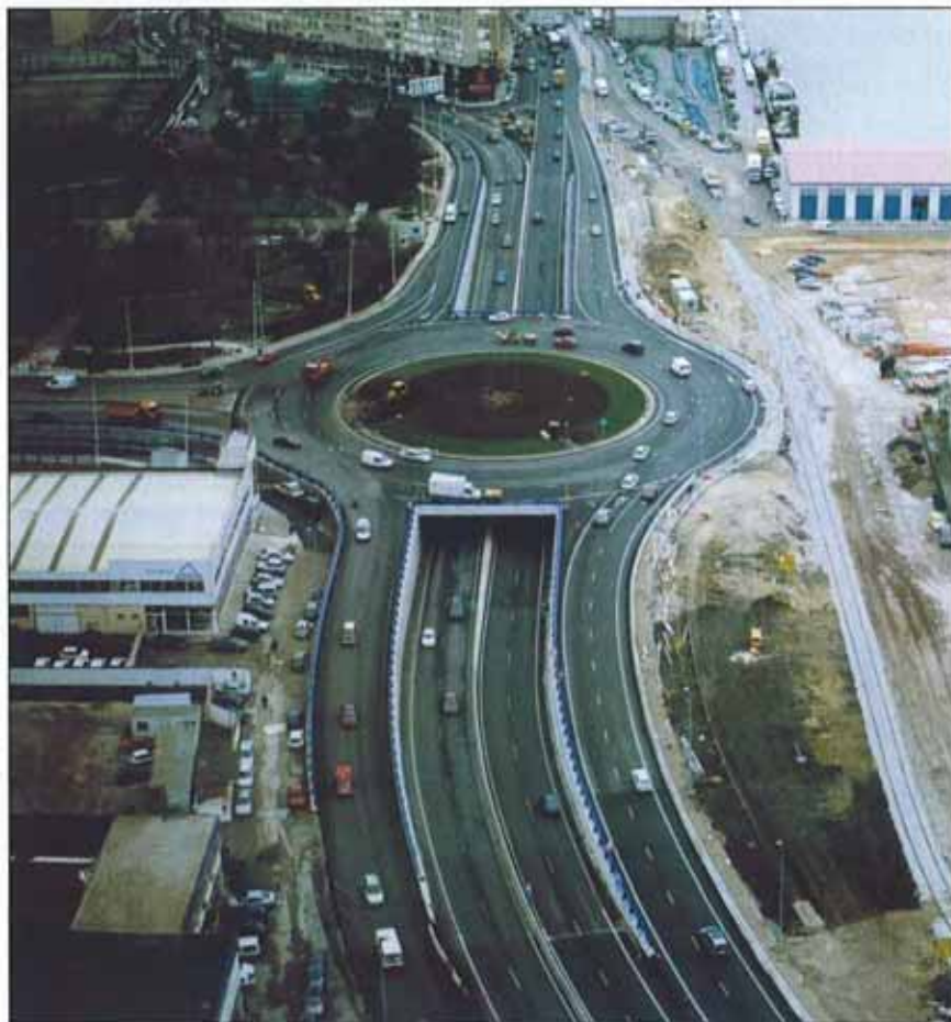
Los ejes principales y el desarrollo de las nuevas glorietas suponen una longitud de 1 370 m.
