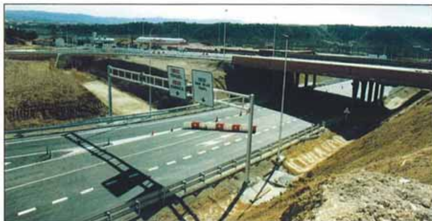
Paso inferior bajo la carretera nacional.
