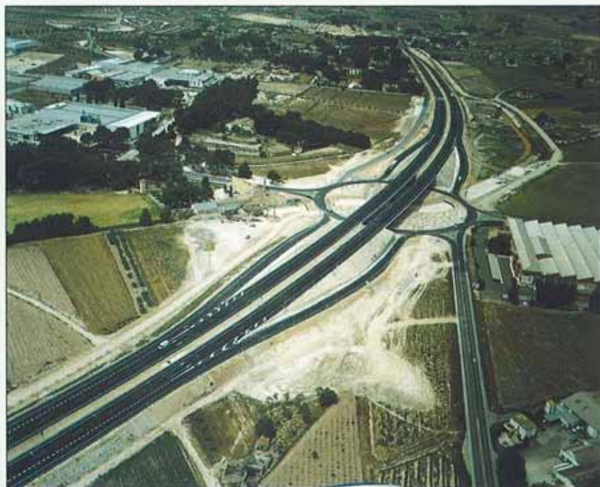
Conexión con la CV-815 (Castalla-Onil).
