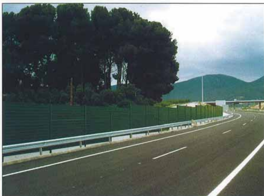
Pantallas antirruido dispuestas para atenuar el impacto acústico que origina el tráfico en las urbanizaciones cercanas a la traza.
