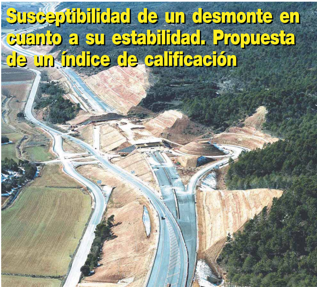
Autovía A-40, tramo Horcajada de la Torre-Abia de la Obispalía. Desmante en arcillas terciarias.
