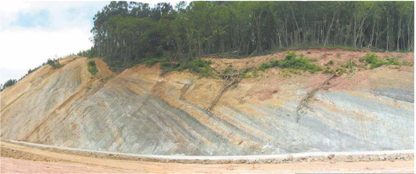
Autovía de la Meseta, tramo Torrelavega-Los Corrales. Desmonte en alternancia de rocas blandas.
