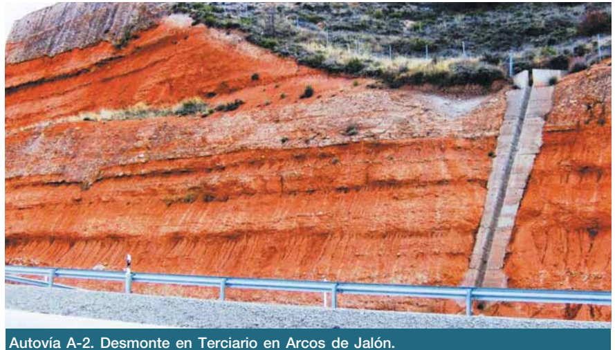
Autovía A-2. Desmonte en Terciario en Arcos de Jalón.
