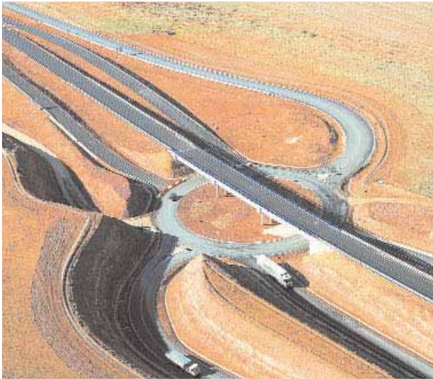
Vista aérea y detalle del enlace de Ayllón.
