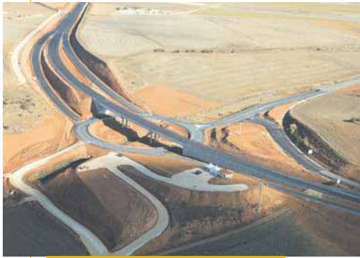
Vista aérea del enlace de Santa María de Riaza.
