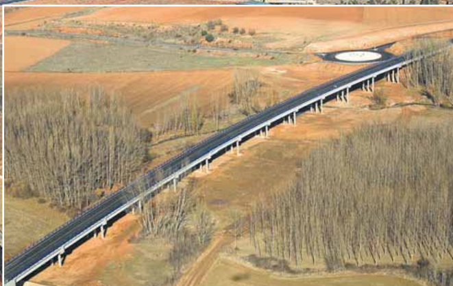
Foto superior: viaducto sobre el río Aguijejo de 420 m de longitud y 14 vanos isostáticos. Foto de fondo: vista general de la variante en la que se aprecian algunas de sus estructuras.
