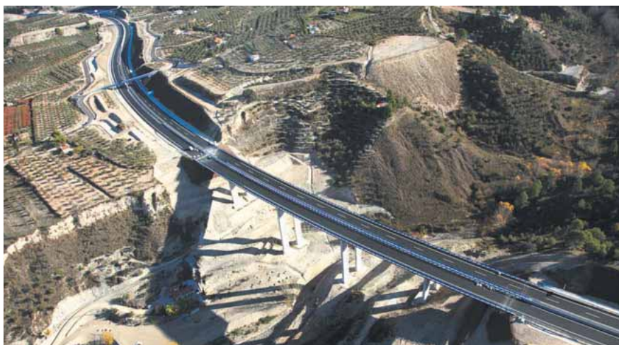
Foto superior: Viaducto Serpis 2. En la foto inferior el viaducto del barranco de Caraita.
