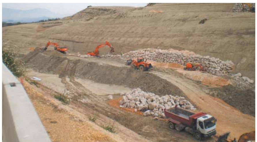
Paso superior de camino (p.k. 6+200) en talud con malla y muro de escollera de 8 y 5 m. En la foto inferior el muro de escollera en fase de ejecución.
