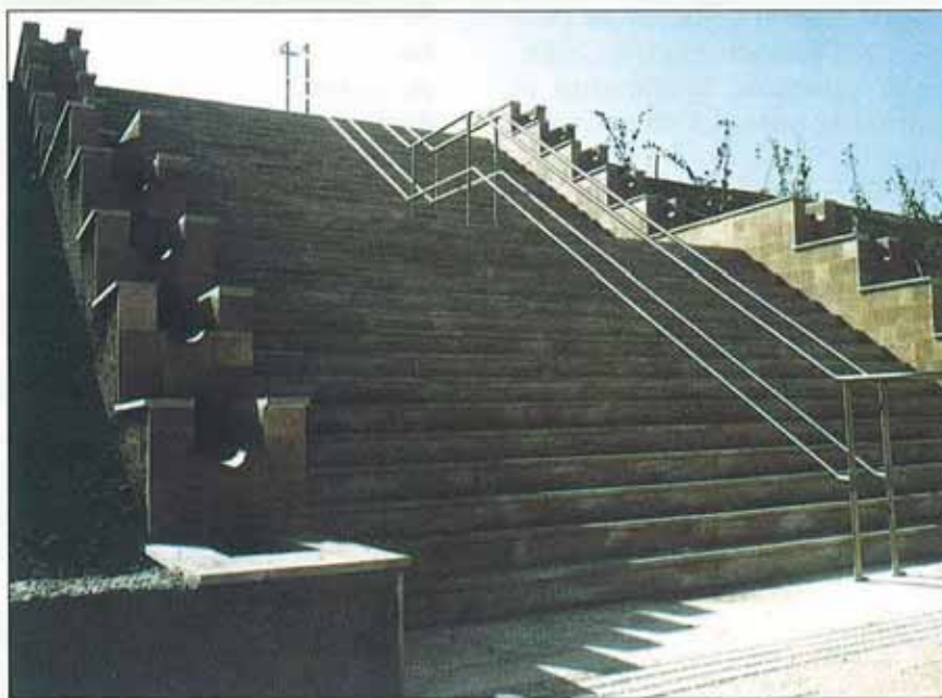
En las fotos se aprecian algunos de los ornamentos y equipamientos utilizados en la Ronda Sur de Valencia.
