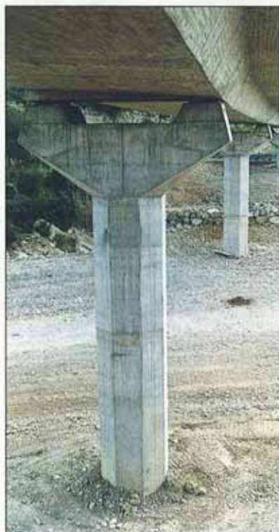
Detalle de las pilas octogonales del viaducto sobre el río Palanca.
