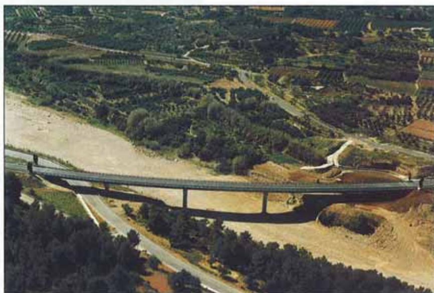
Viaducto sobre el río Palancia.
