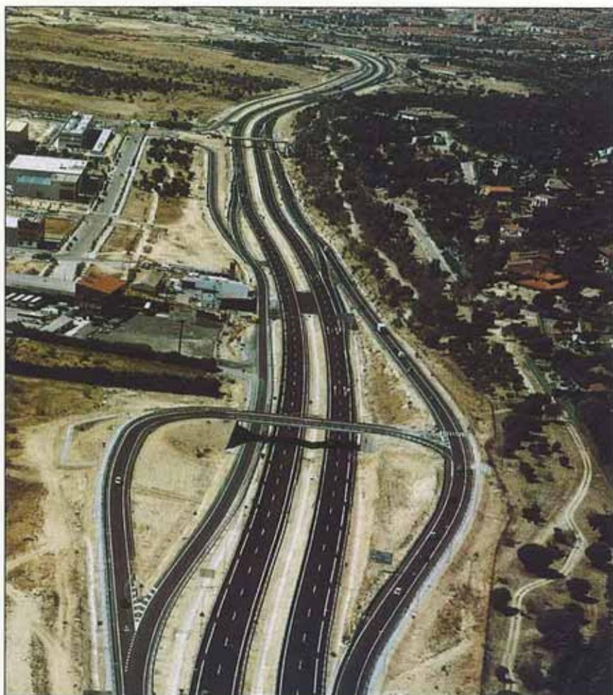
El tronco de la nueva autovía consta de 2 calzadas de 7 m, con 2 carriles de 3,5 m cada una, arcenes exteriores de 1,5 m e interiores de 1 m, con mediana de 8 m.
