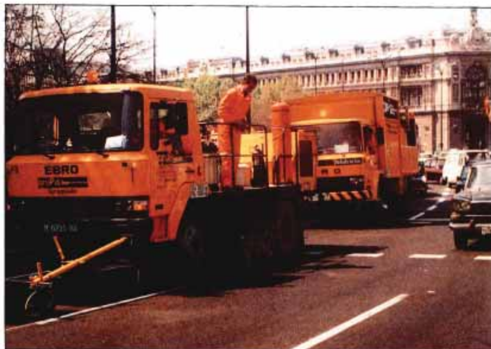
Aplicación del termoplástico en caliente (SPRAYPLASTIC) en Madrid.
