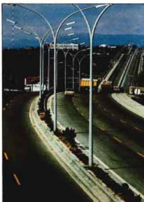
Duración y visibilidad, dos cualidades de la señalización horizontal.
