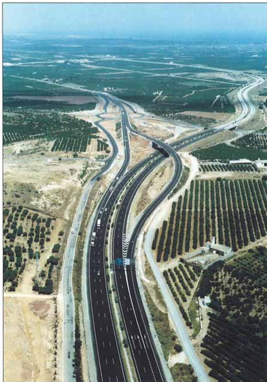
Autopista con N-340, enlace Sagunto norte. Final del tercer carril en sentido norte, e inicio del tercer carril en sentido sur.
