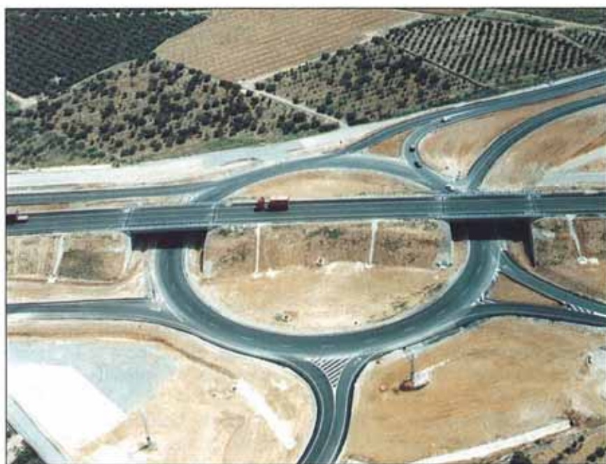
Glorieta en el enlace de Sagunto Norte.
