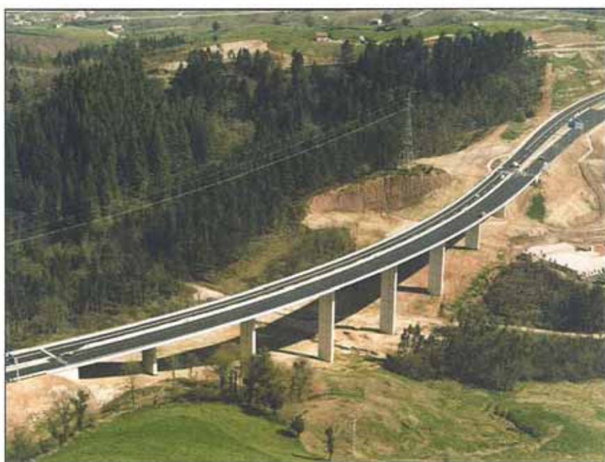
Viaducto de Las Navas.
