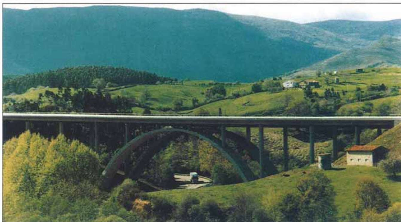
Viaducto de Caviedes.
