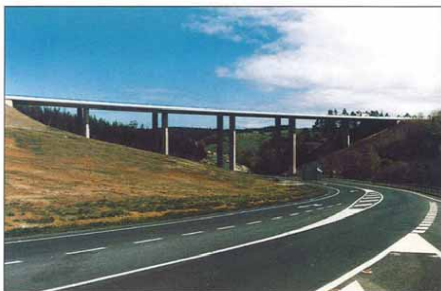
Viaducto de Roiz
