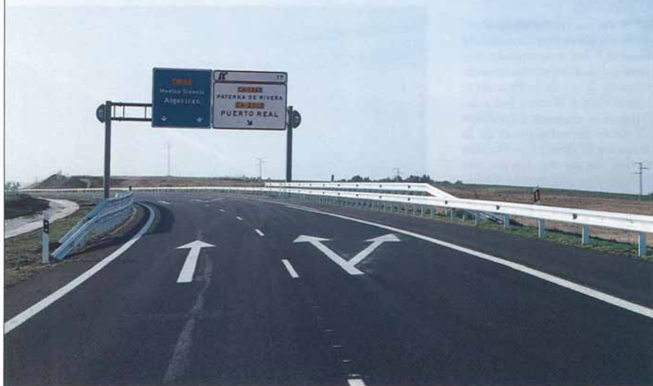
Vista parcial del tramo II.
