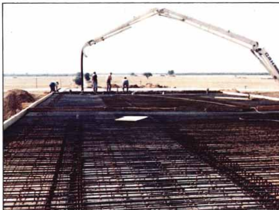
Detalle del hormigonado del tablero.
