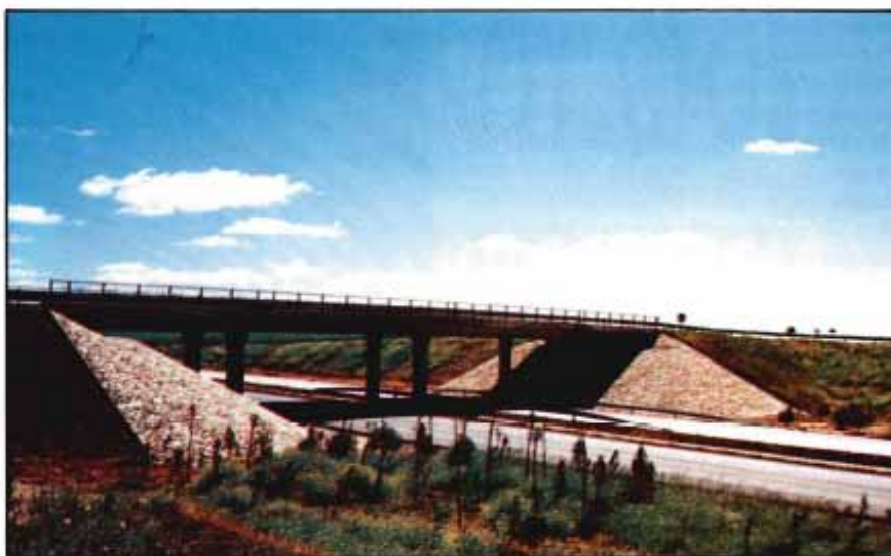
Paso superior enlace de Bnhuega. PV. 83.400.
