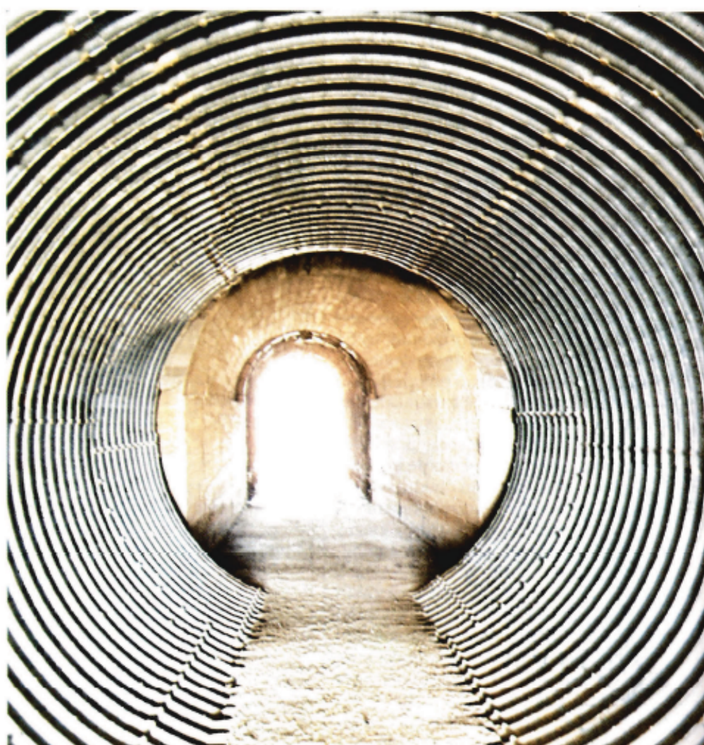
Vista interior del tubo ondulado colocado en la obra de drenaje 23 + 045 como prolongación de una antigua obra de fábrica.
