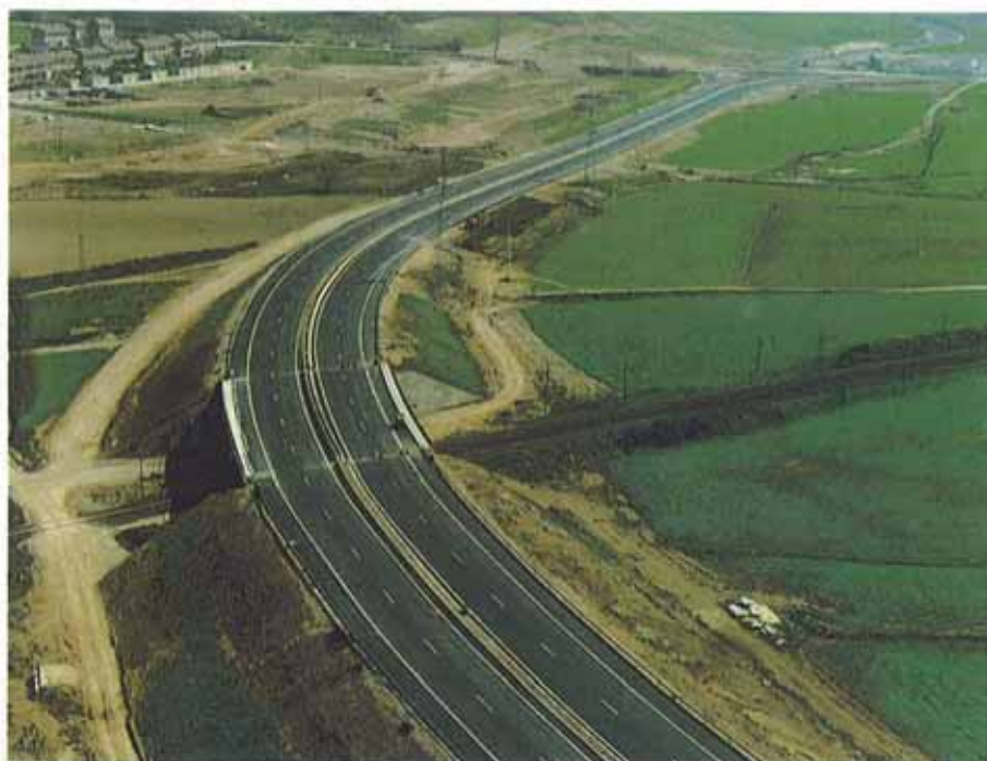
Ronda Norte: Tramo de doble calzada a su paso por Artica.
