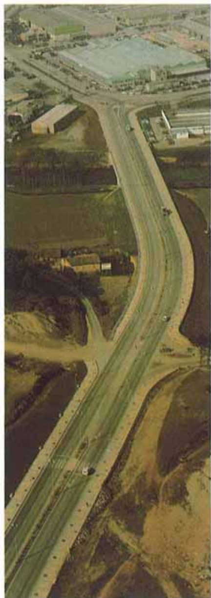
Barañain-Landaben. Obra complementaria del cinturón
