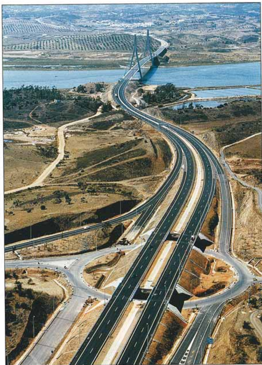
Vista del enlace Lepe Oeste. Al fondo, el puente internacional de Ayamonte.
