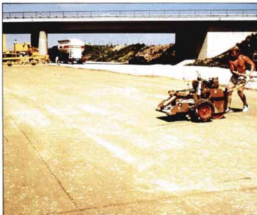
Fig. 9a.— Creación de juntas en fresco en una base tratada con cemento para control de la fisuración (R.F. Alemana)
