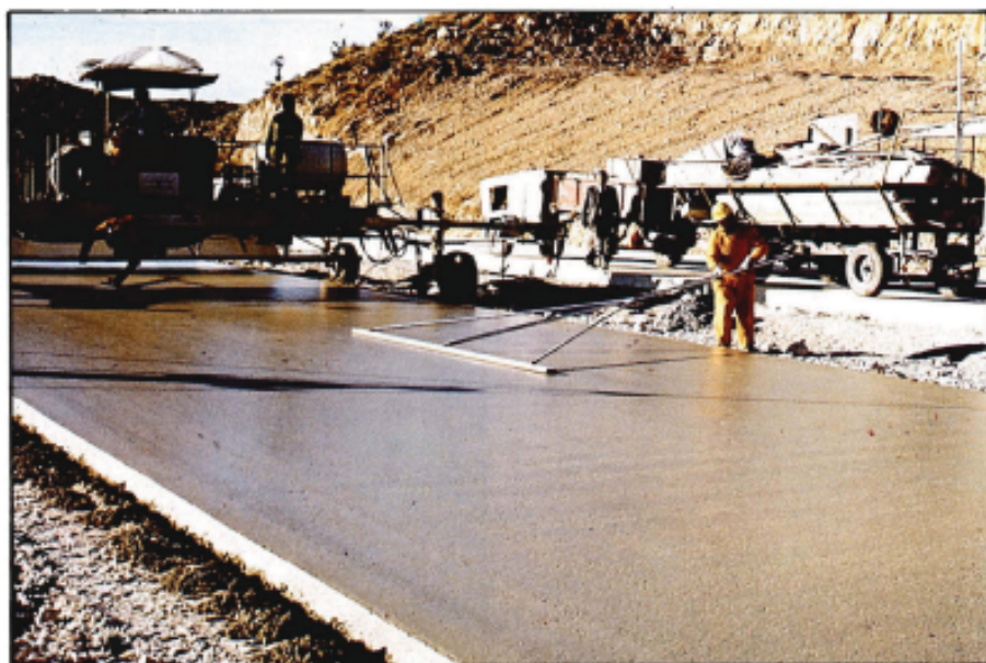
Fig. 2 — Base de hormigón magro resistente a la erosión (autopista del Mediterráneo, tramo Jerez-Óndara).
