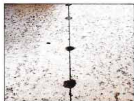
Fig. 20a y b— Conector para restauración de la transferencia de cargas en las juntas (Francia)
