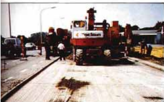
Fig. 10a.— "Inlay" de hormigón armado con fibras (Bélgica)
