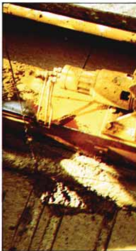
Fig. 16a y b. Junta longitudinal formada en fresco mediante una cuchilla fija fijada a la pavimentadora (autopista A32, R.F. Alemania)
