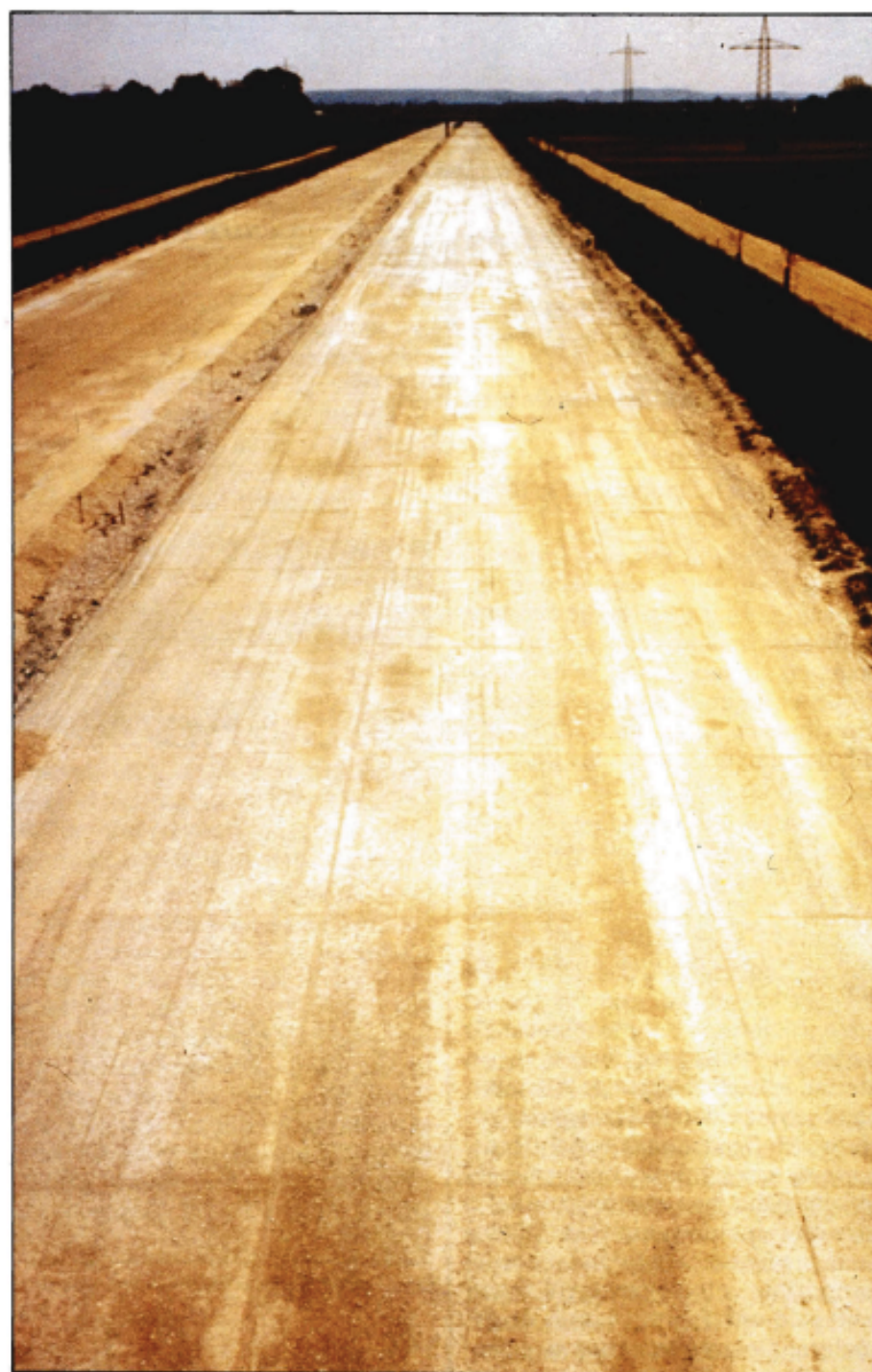
Fig. 9b.— Creación de juntas en fresco en una base tratada con cemento para control de la fisuración (R.F. Alemana)
