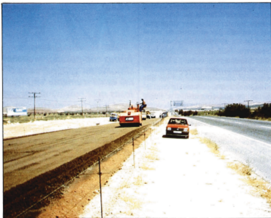
Fig. 8.—Duplicación de calzada con un pavimento de hormigón compactado (Valdepeñas-Almuradiel)
