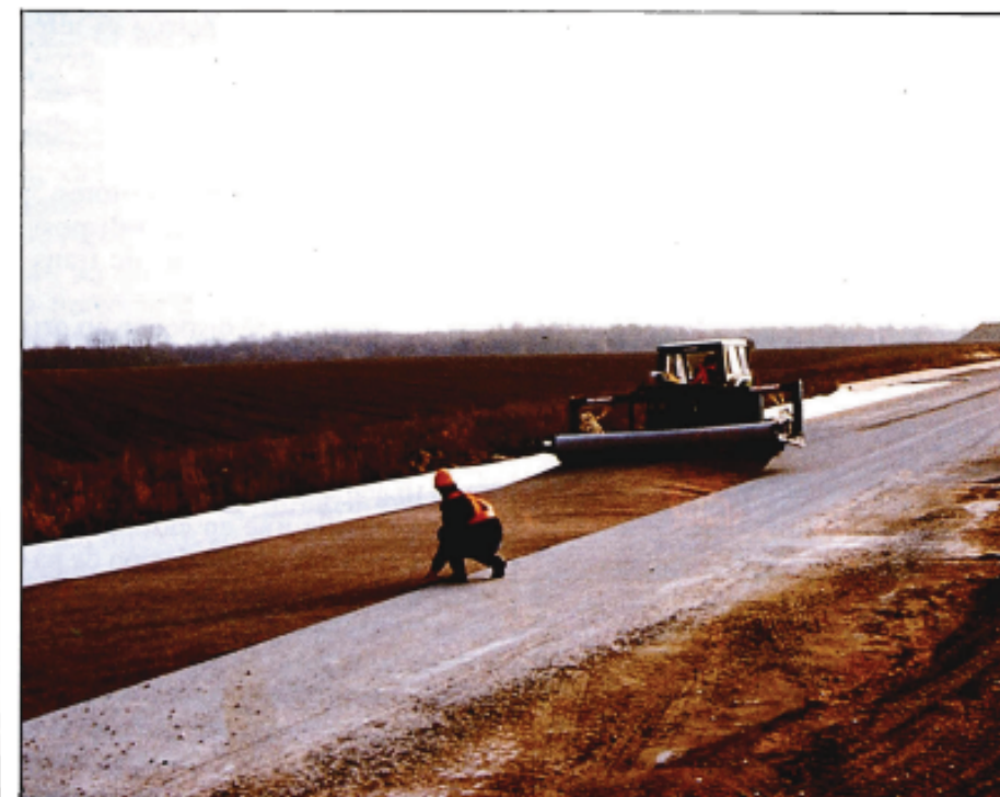
Fig. 21.— Extensión de la moqueta drenante (autopista A26, Francia)
