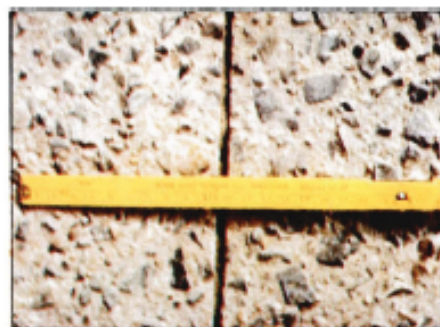
Fig. 17a y b— Tratamiento de la superficie del hormigón mediante denudado (autopista A6 Francia)
