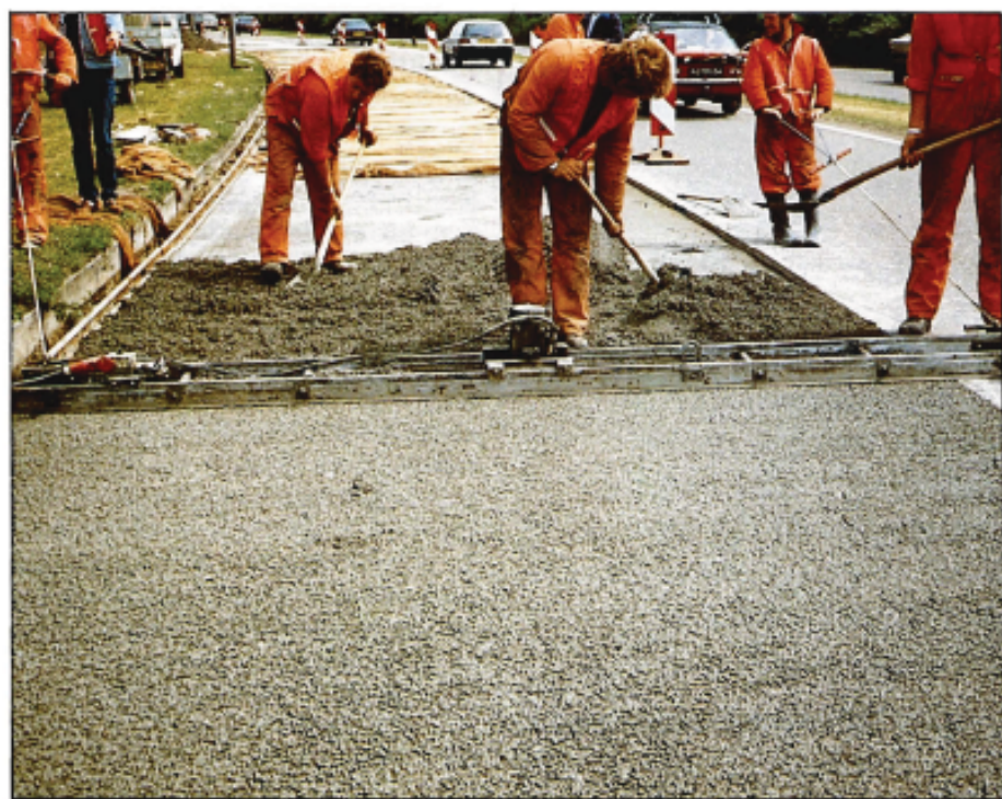
Fig. 11a y b.— Empleo de hormigón poroso en capa de rodadura (Holanda)
