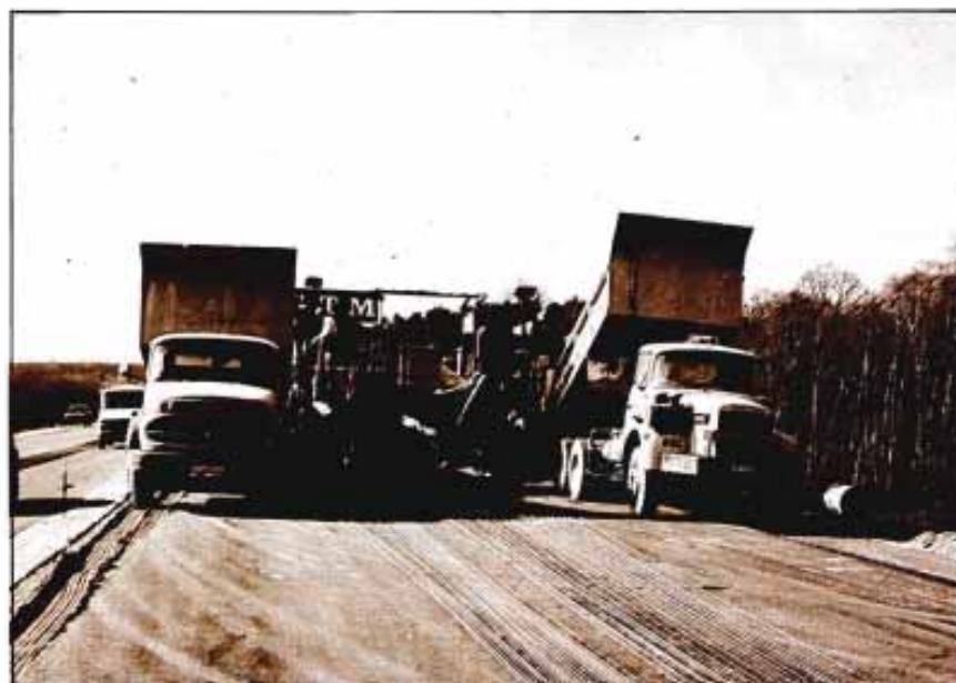
Fig. 7.— Armaduras agrupadas en el centro de la base para permitir la alimentación frontal del hormigón (autopista A71, Francia)
