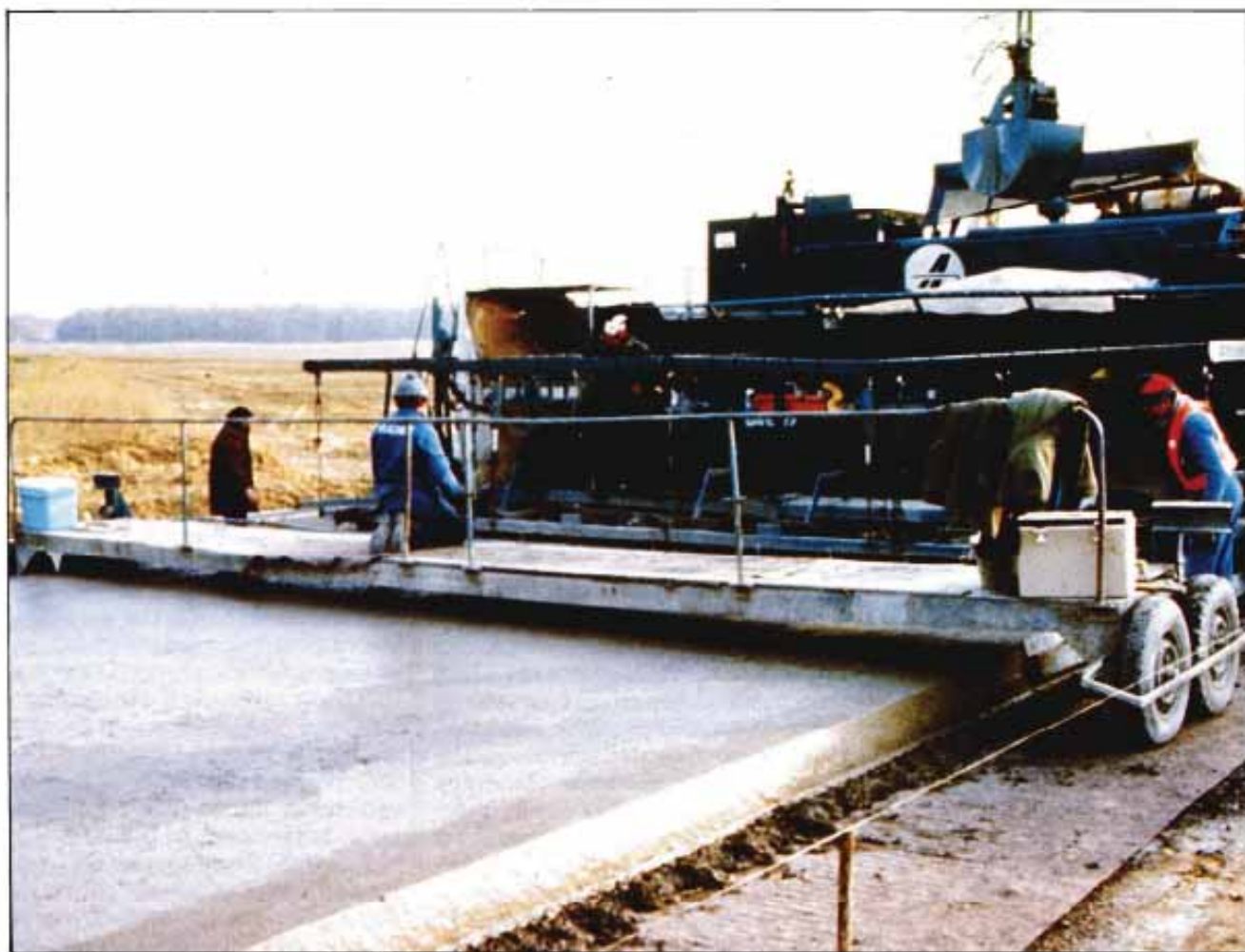
Fig. 5.— Losa gruesa sobre moqueta drenante (autopista A26, Francia)
