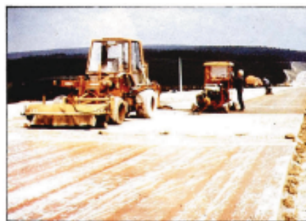
Fig. 17a y b— Tratamiento de la superficie del hormigón mediante denudado (autopista A6 Francia)
