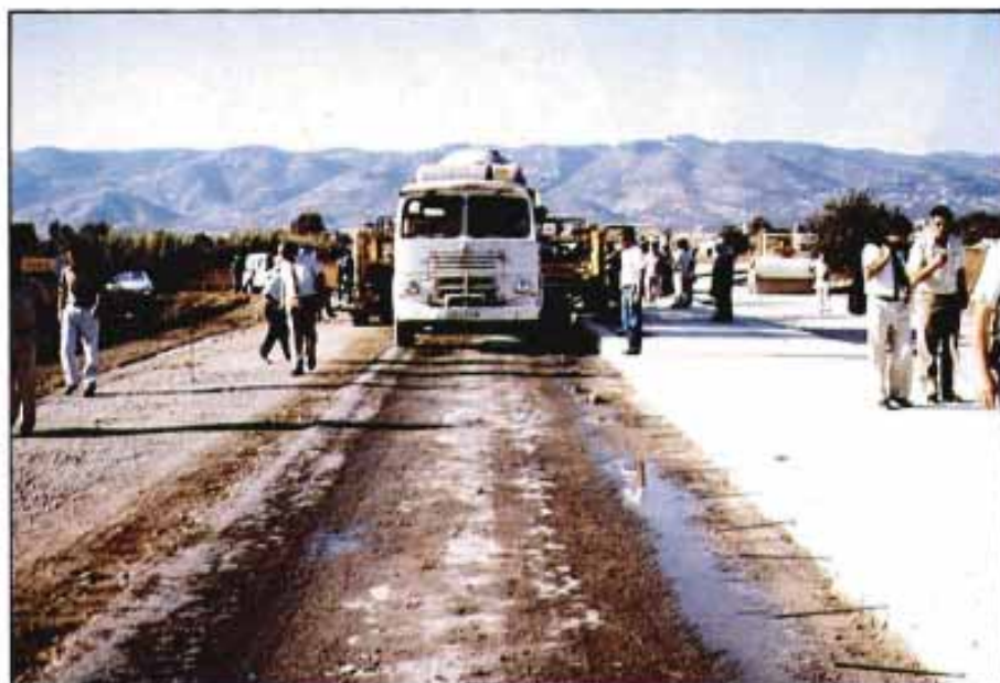
Fig. 24.— Refuerzo con hormigón de un pavimento asfáltico (carretera CO-123, Córdoba)
