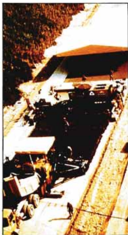
Fig. 15. Preextendido del hormigón con extendidora de aglomerado (R.F. Alemania)
