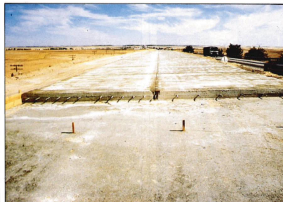
Fig. 4 — Pasadores en una junta final de losa (variante de Aranjuez).
