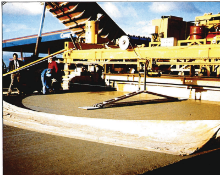
Fig. 14.—Maestra oscilante para mejora de la regularidad superficial y arpillera para creación de microtextura (Trinqueque-intersección C-204)
