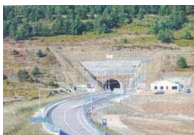
Túnel de Piqueras. 2008 L: 2.444 m
