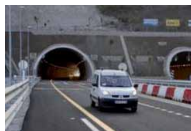
Túnel de Cantalobos. 2009 L: 2.170 m
