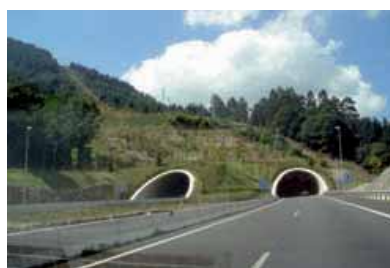
Túnel de Gedo. 2005 L: 2.500 m
