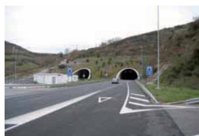
Túnel de Pedredo. 2005 L: 1.100 m
