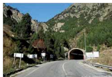
Remodelación Túnel de Bielsa. 2010 L: 3.070 m
