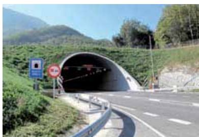
Túnel de Bracons. 2009 L: 4.556 m
