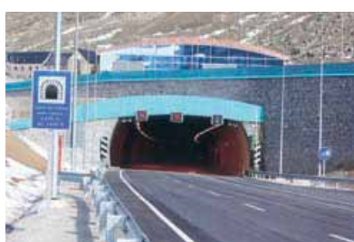
Túnel de Viella. 2007 L: 5.200 m
