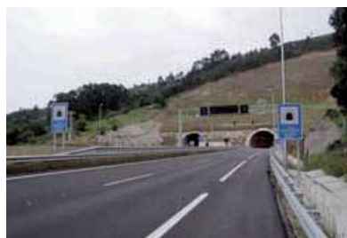
Túnel de Fabar. 2002 L: 1.362 m
