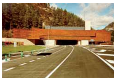
Túnel de Somport. 2003 L: 8.608 m
