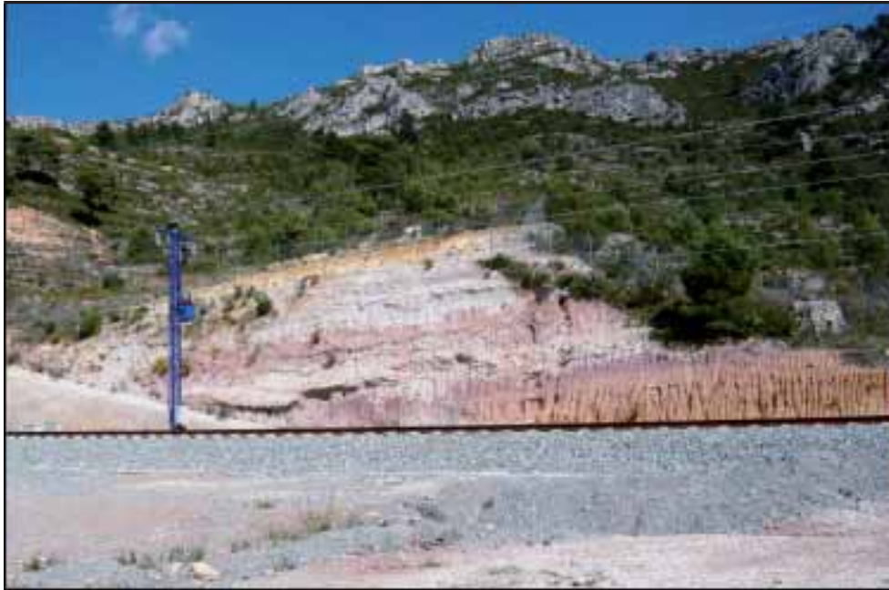
Figura 12.- Fotografía de la ladera en la boquilla Este del Túnel de Lilla. Se aprecian bien las arcillas con yesos a cota de la vía y las calizas superiores.
