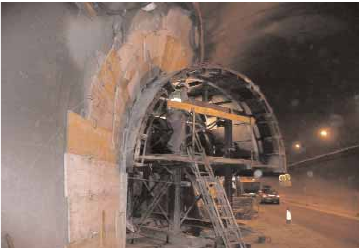
Última puesta de revestimiento de hormigón en galería sur
