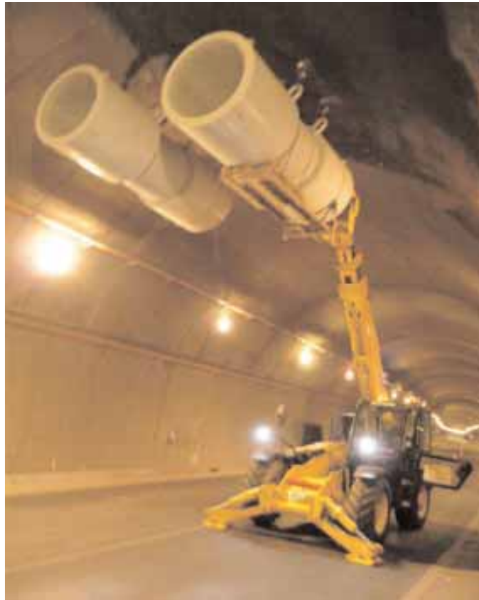
COolocación de ventiladores
