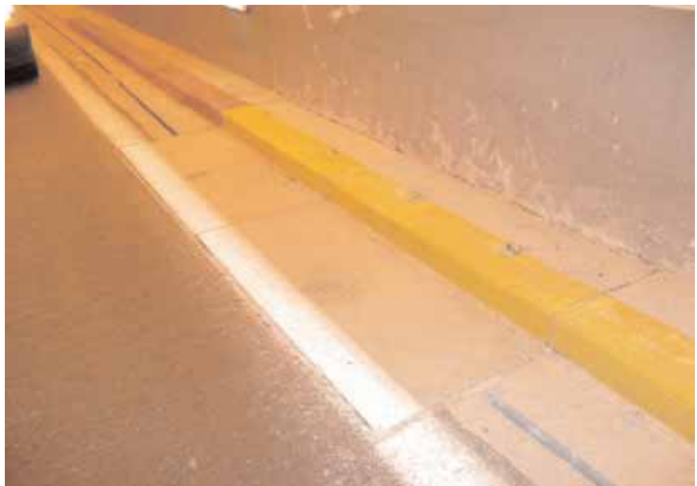
Ejecución de drenaje de tóxicos (fase final arquetas)
