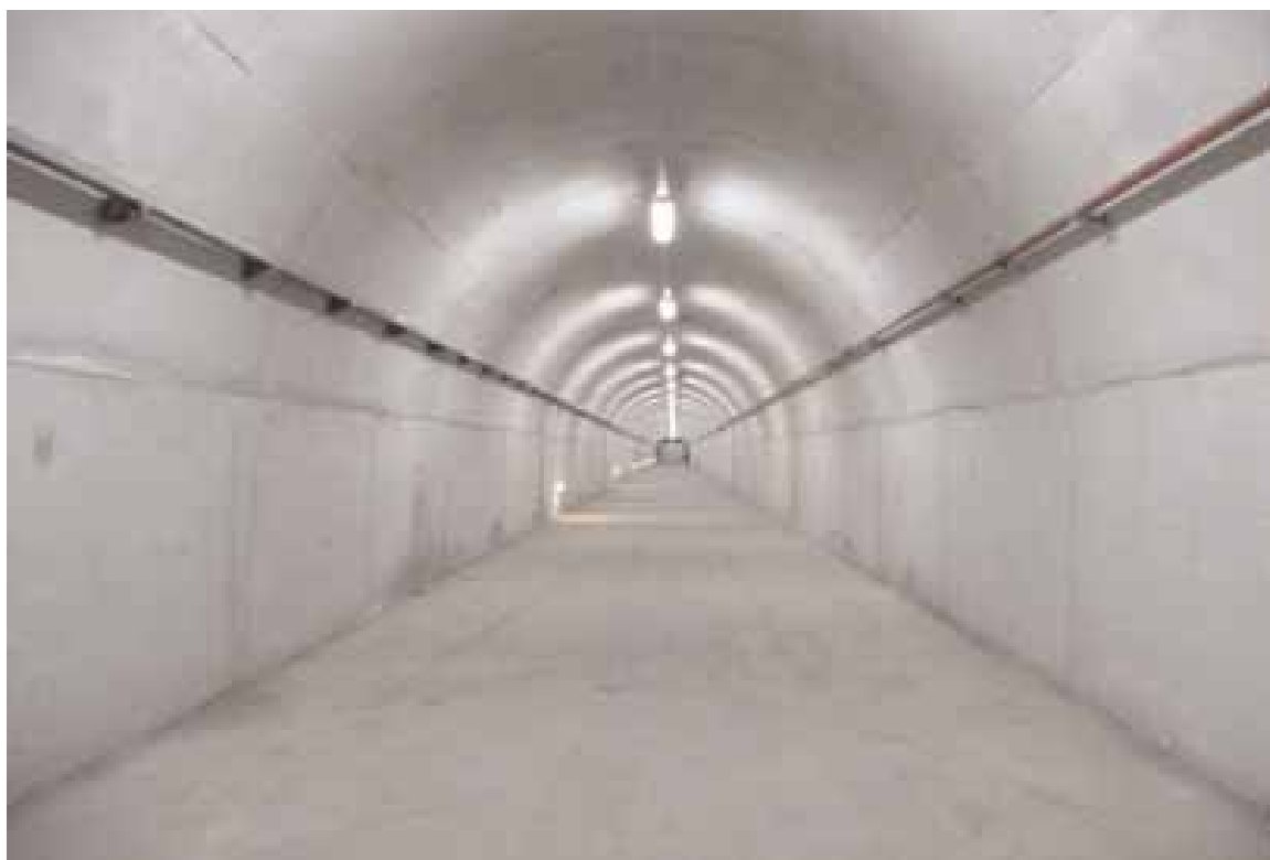
Galería en ejecución (fase final)
