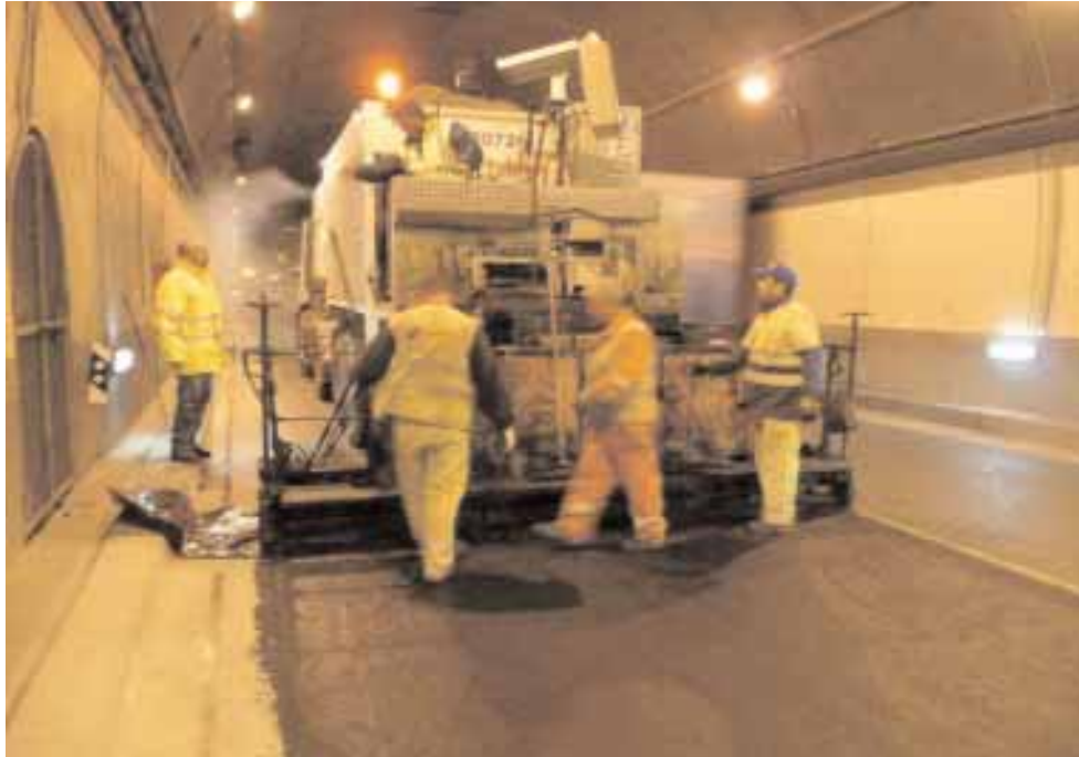
Extendido de lechada bituminosa
