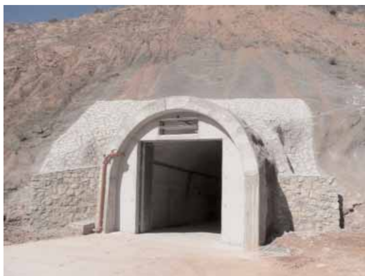
Boca de galería sur a cielo abierto
