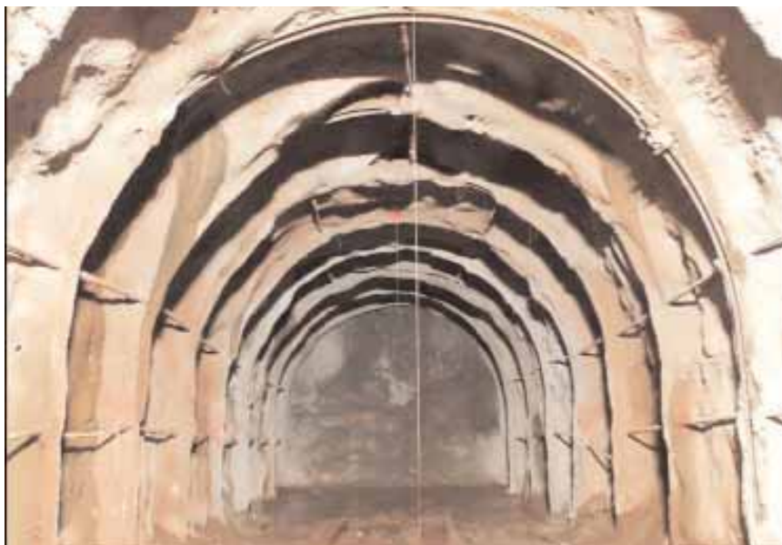
Avance del sostenimiento con cerchas, bulones y gunitado
