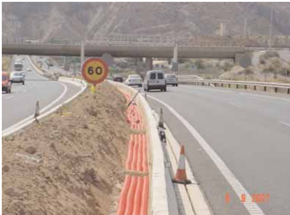
Canalizaciones por mediana
