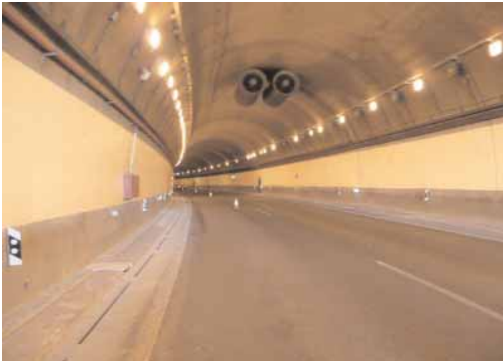
Drenaje de tóxicos después de las obras
