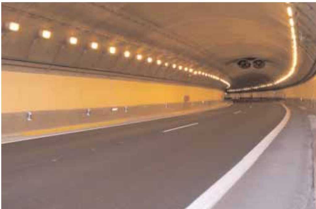
Vista del túnel después de las obras
