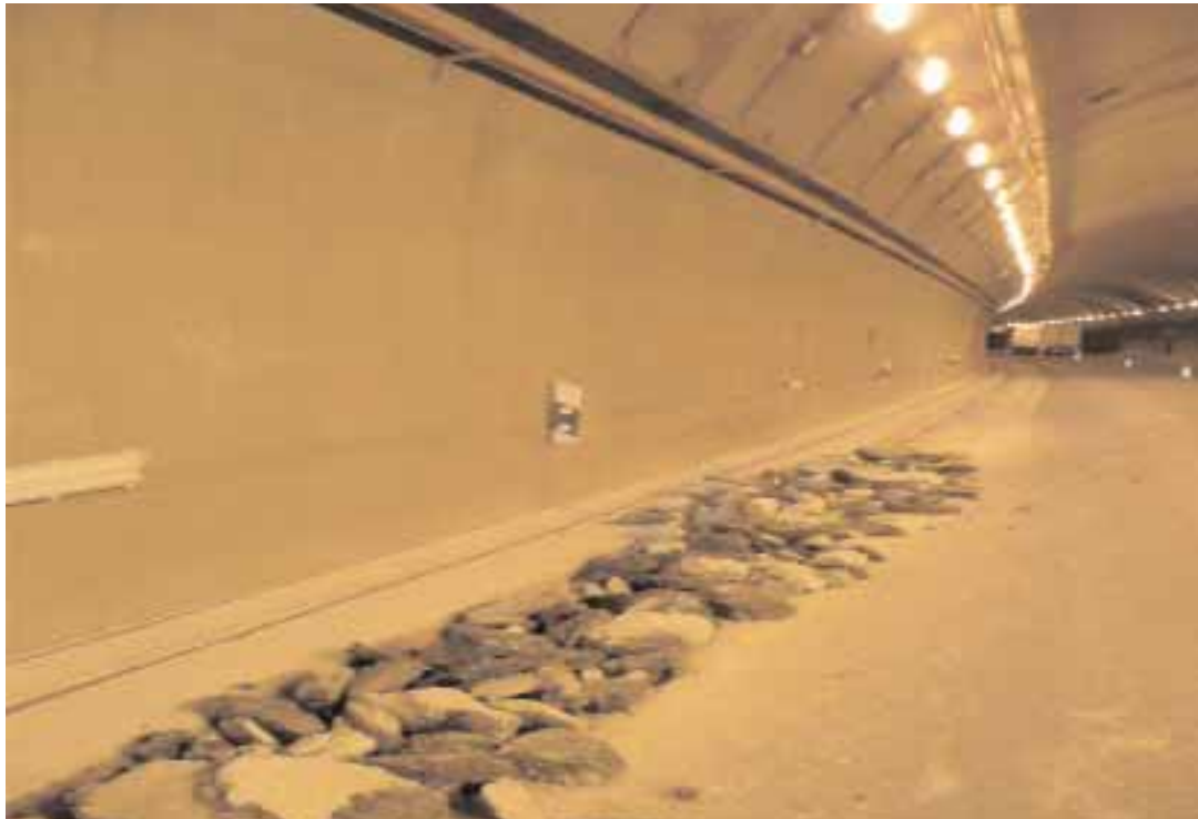
Ejecución de drenaje de tóxicos (fase inicial)
