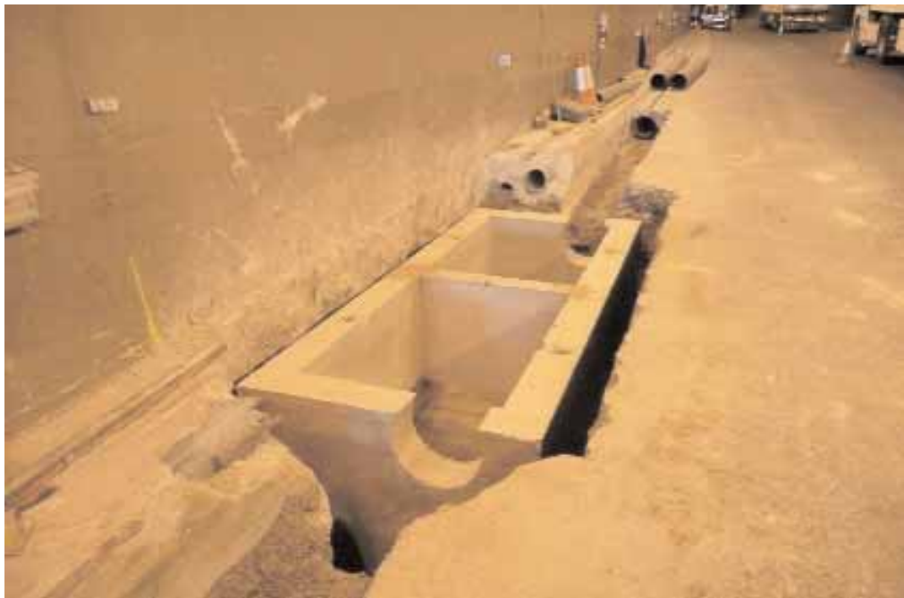
Ejecución de drenaje de tóxicos (fase arquetas)
