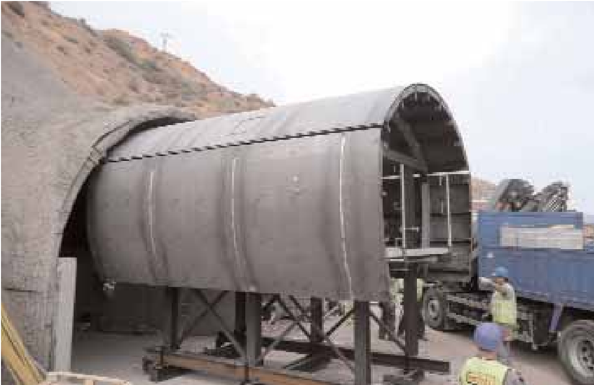
Carro de encofrado
