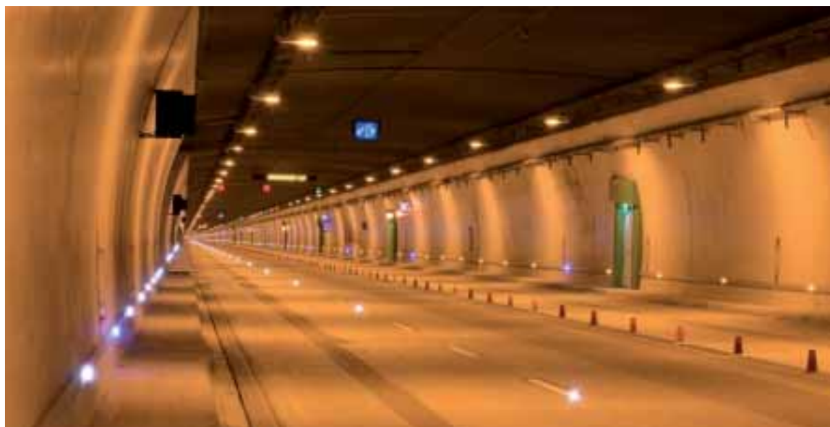
Figura 17 Túnel Juan Carlos I (Vielha)
