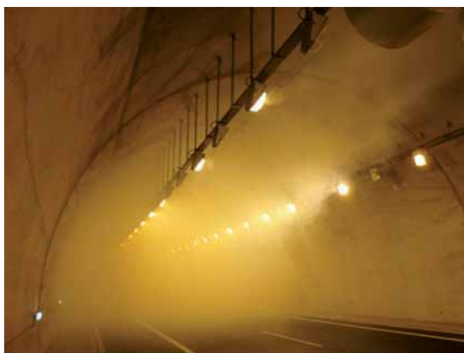
Fig 10. Ejemplo de actuación incorrecta de la ventilación en Zarimutz
