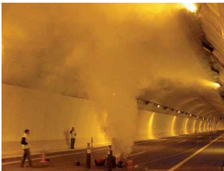
Fig 3. Montaje de equipos de medición en el túnel
