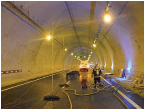
Fig 6. Preparación del foco del incendio
