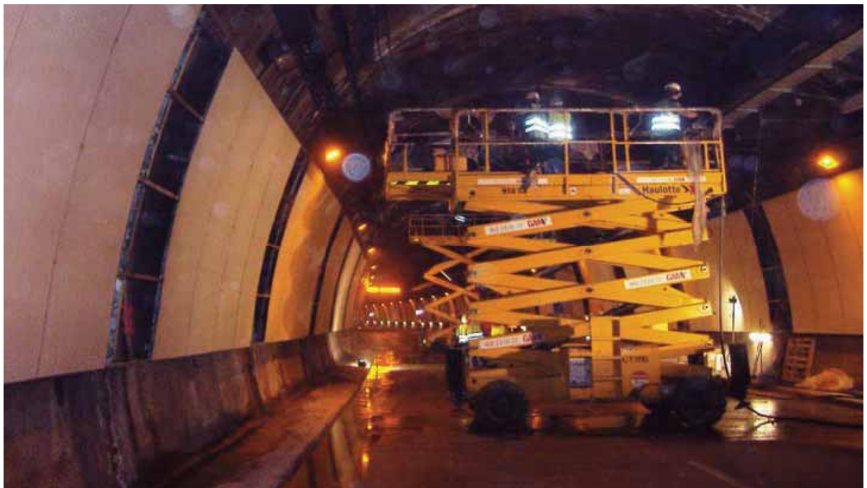
[Figura 3] Trabajos de sellado de juntas desde tijeras elevadoras, en el túnel descendente.
