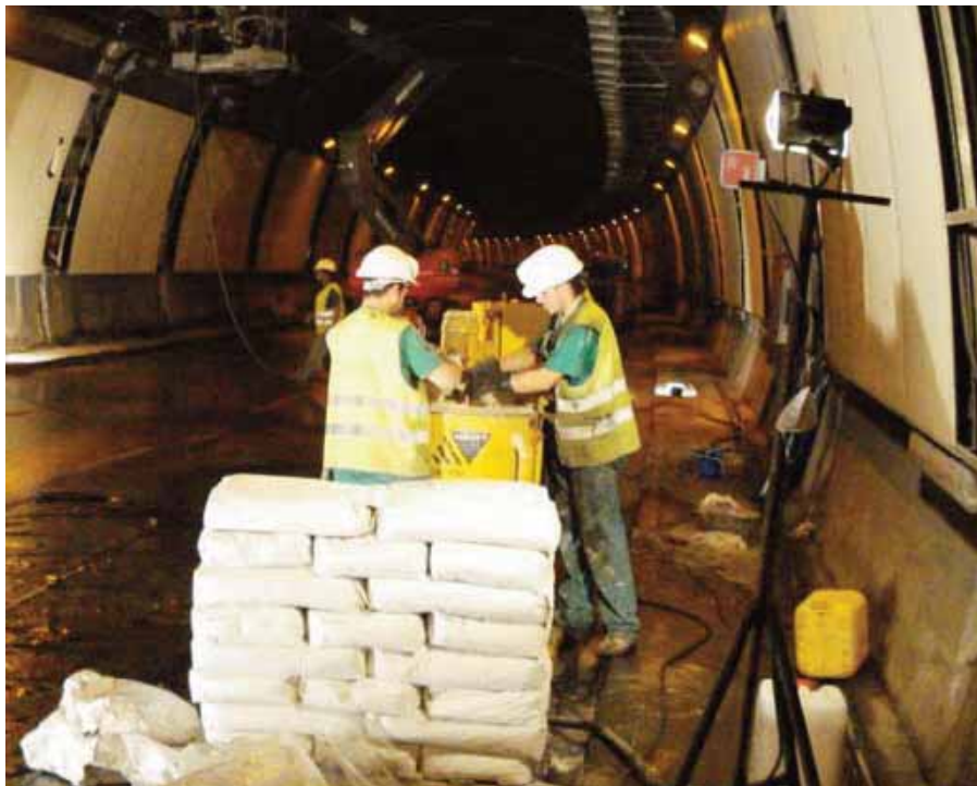
[Figura 7] Fabricación de lechada a base de Bentocem® suministrado en sacos, con bomba Hány.
