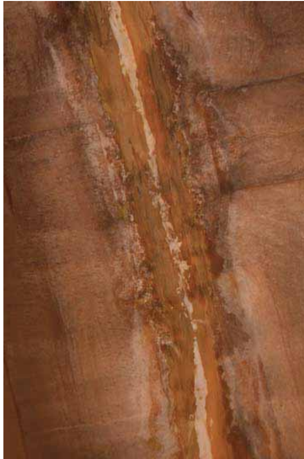
[Figura 9] Detalle de junta sellada y con banda colocada.
