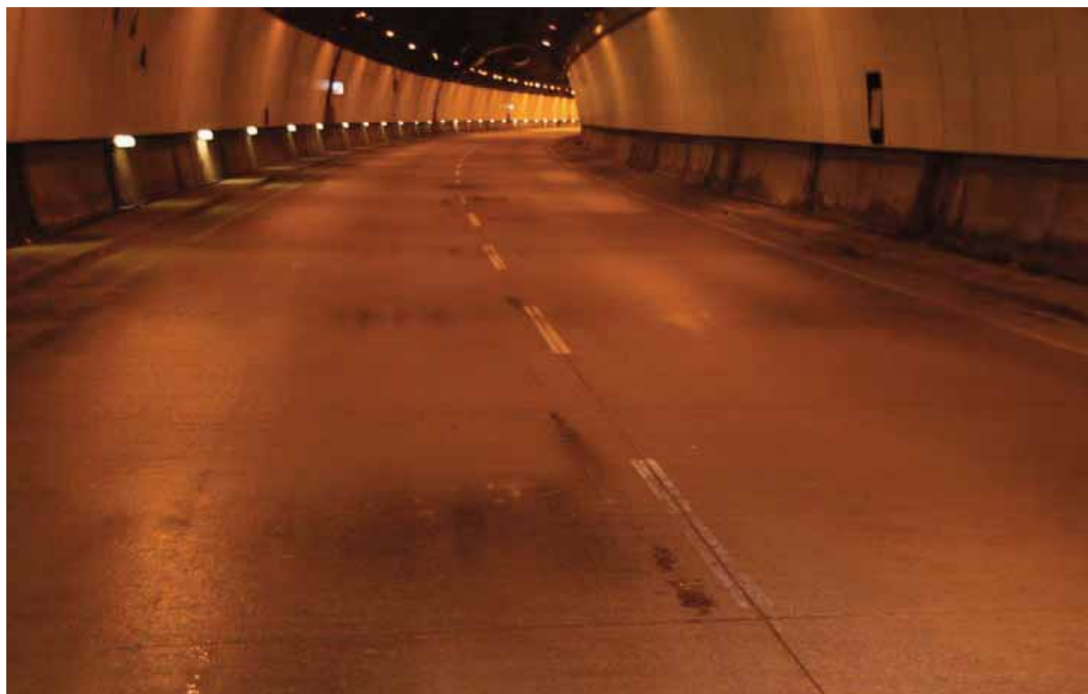
[Figura 1] Vista de uno de los túneles de la Rovira
