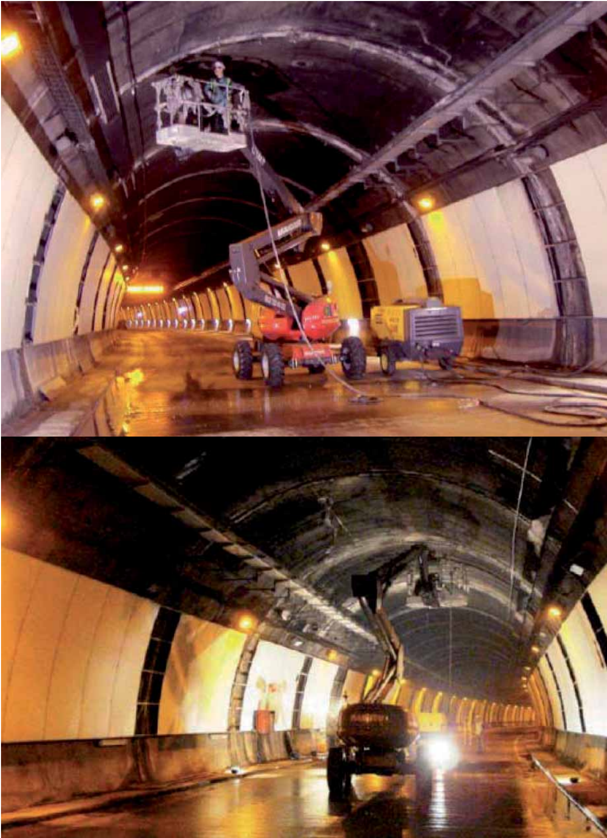
[Figuras 5 y 6] Inyección de las válvulas colocadas en la clave del túnel desde cesta autopropulsada.
