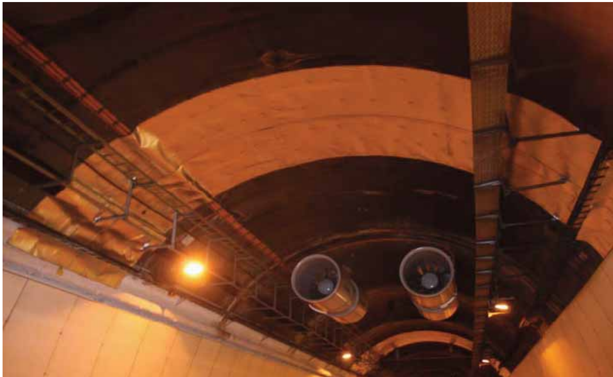
[Figura 11] Vista de un tramo del túnel con la lámina Carfoam® adaptada a las instalaciones existentes.
