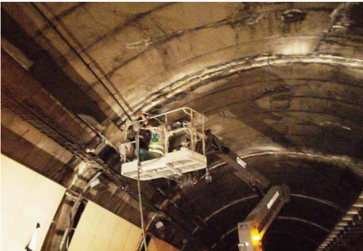
[Figura 8] Detalle de la operación de obturación de la válvula.
