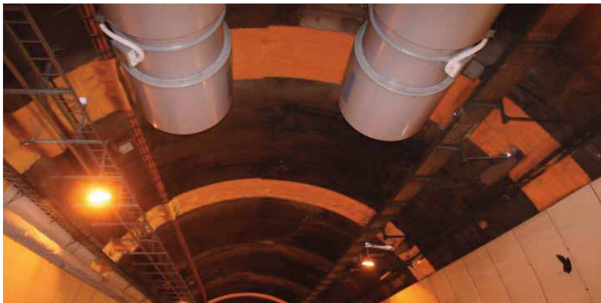
[Figura 10] Detalle de las láminas Carfoam® colocadas.
