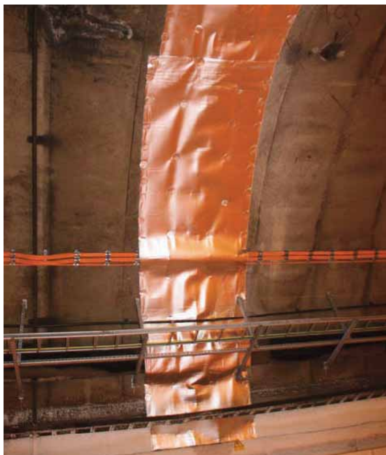
[Figura 12] Detalle de la lámina Carfoam® adaptada a las instalaciones existentes.
