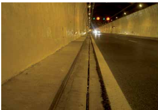
Sistema de recogida de vertidos en calzada en los túneles antiguos
