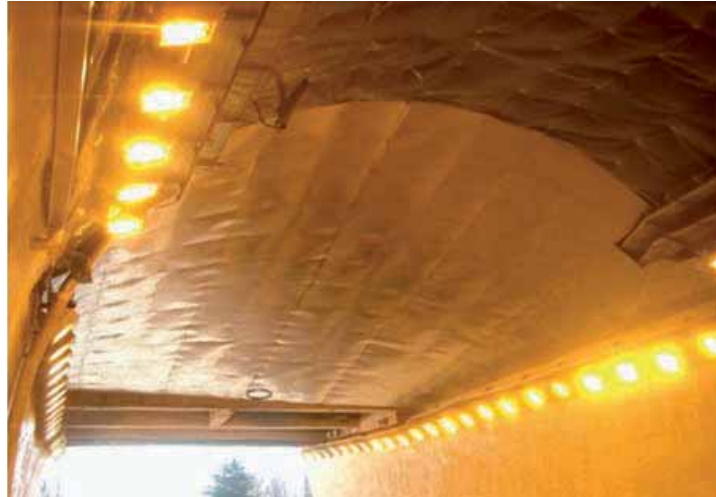
Estructura de transición de sección en bocas del túnel 1
