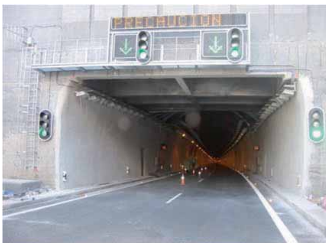
Adecuación de gálibo en bocas del túnel 1
