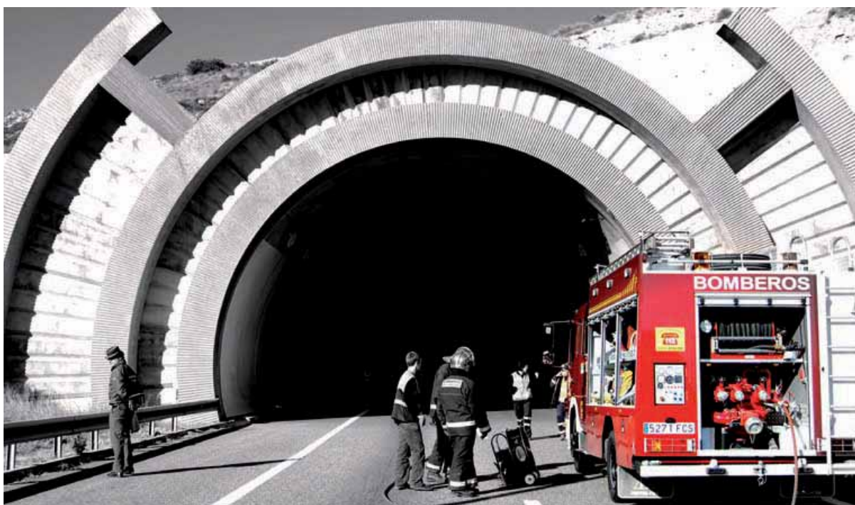
Boca del túnel de San Simón durante los preparativos del simulacro
