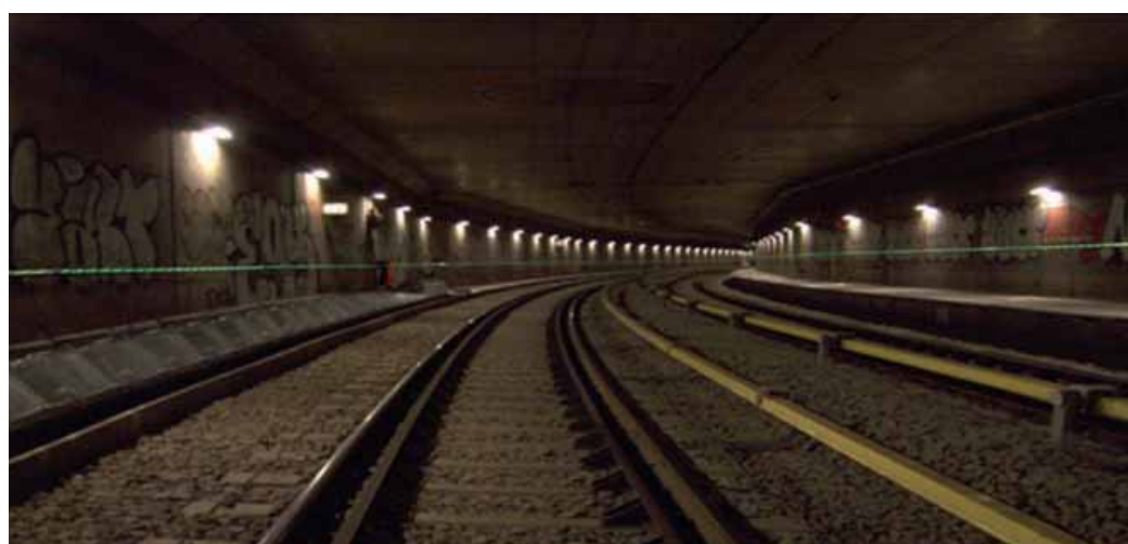
Figura 4.- Ejemplo de aplicación en túnel ferroviario.
