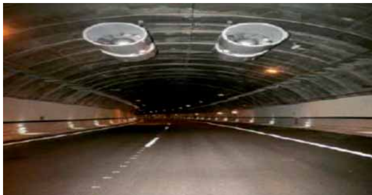
Figura 4: Sistema de ventilación longitudinal en un túnel
