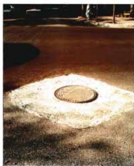
Detalle en zona de tapa de registro
