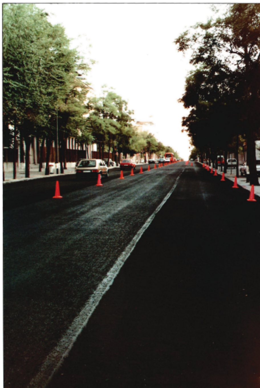
Vista general una vez extendida la 2ª capa.
