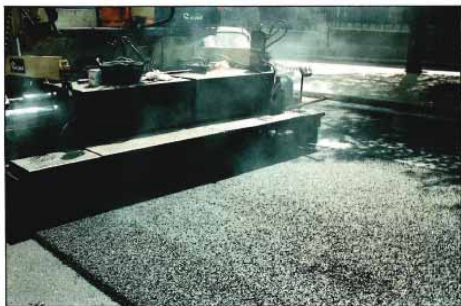
Detalle del extendido pavimento "MEDIFLEX"
