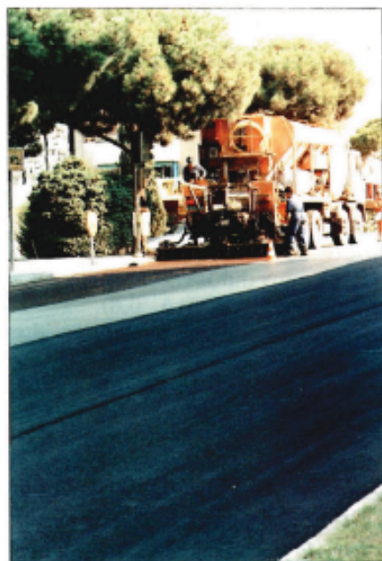
Extensión de lechada bituminosa LB-3 como capa de impermeabilización.
