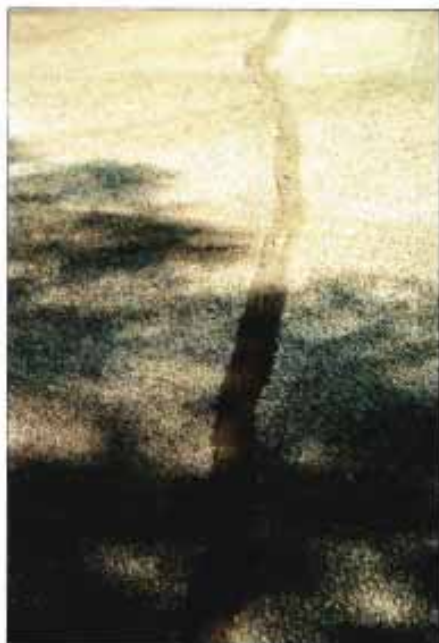
Sellado de fisura
