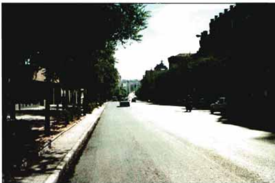
Aspecto general con el nuevo pavimento finalizado.
