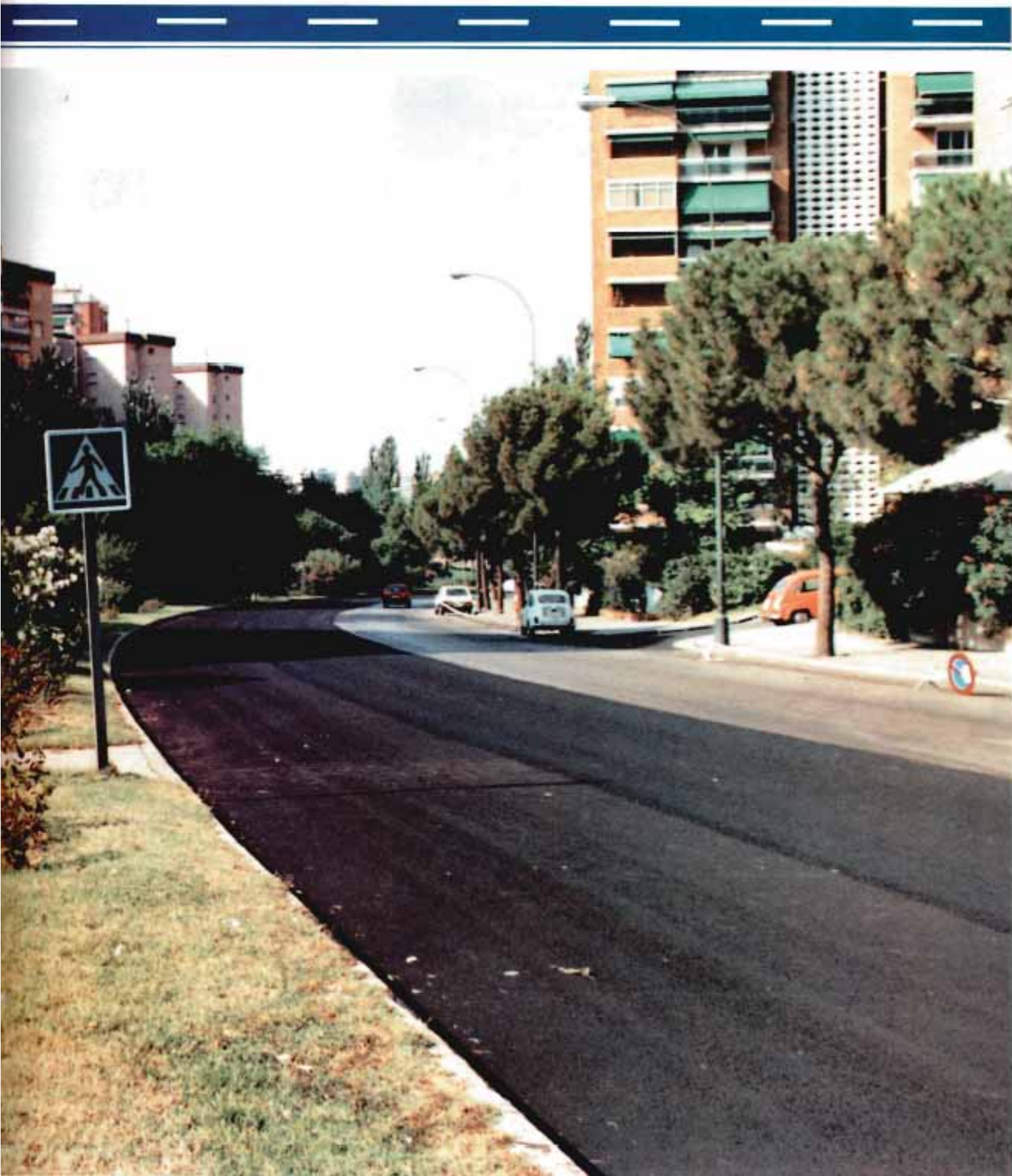
Capa de impermeabilización.
