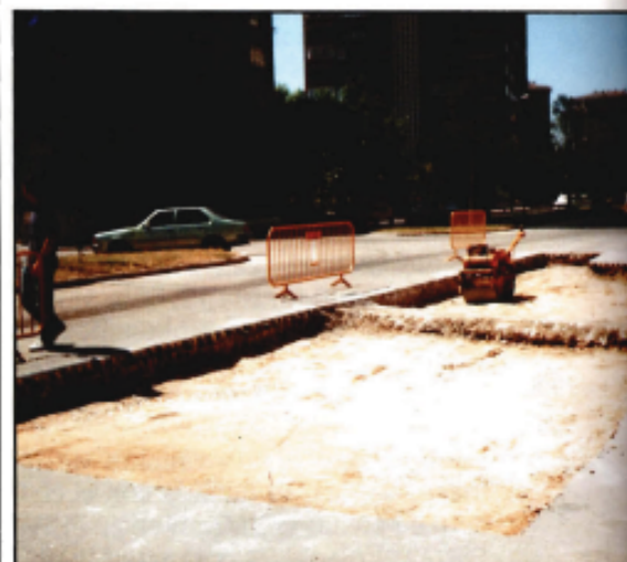
Saneamiento y reparación del firme en la C/ Arturo Soria.
