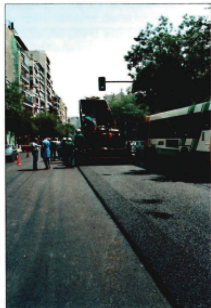
Aspecto general del extendido del pavimento "Mediflex".
