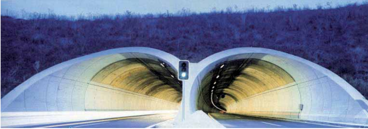
Figura 5. Falso túnel y restitución topográfica
