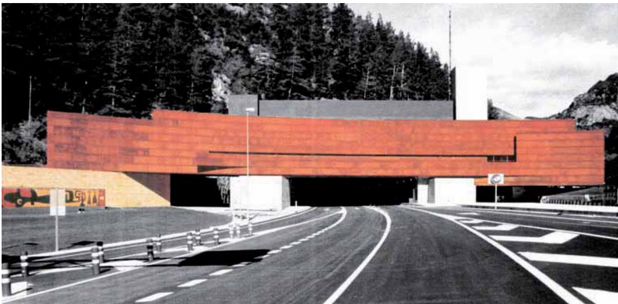
Figura 18. Acceso al túnel de Somport
