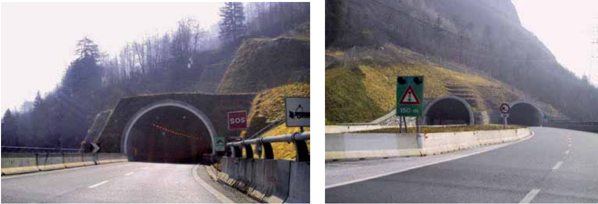
Figura 12 y 13. Restitución de túneles en la A5 italiana en el tramo entre Aosta y el túnel del Montblanc
