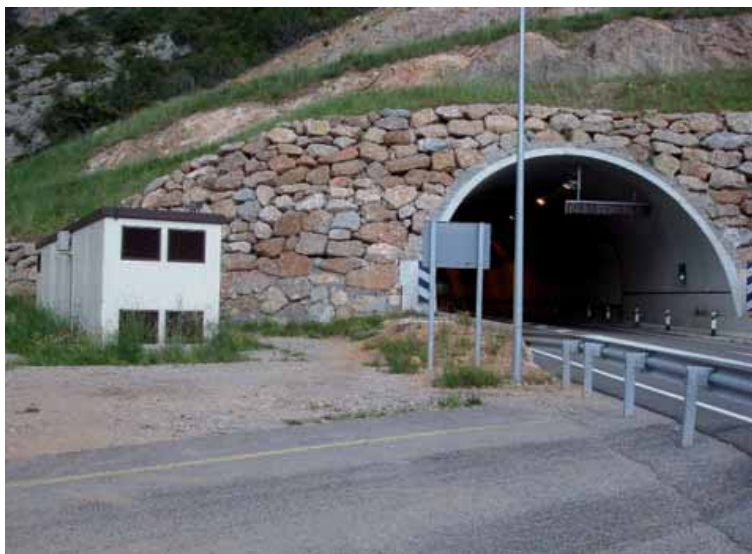
Figuras 26 y 27. Elementos espacios no proyectados afean el aspecto del emboquille.
