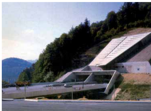
Figuras 23, 24, 25 y 26. Ejemplos de continuidad entre estructuras de túneles y viaductos
